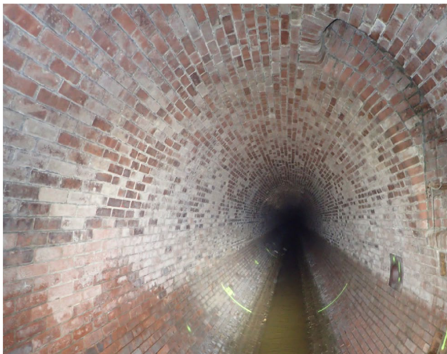
Obr. č. 25: Pohled do stoky v ulici U Seřadiště od Š06 po toku (Sismilich, 2019).
