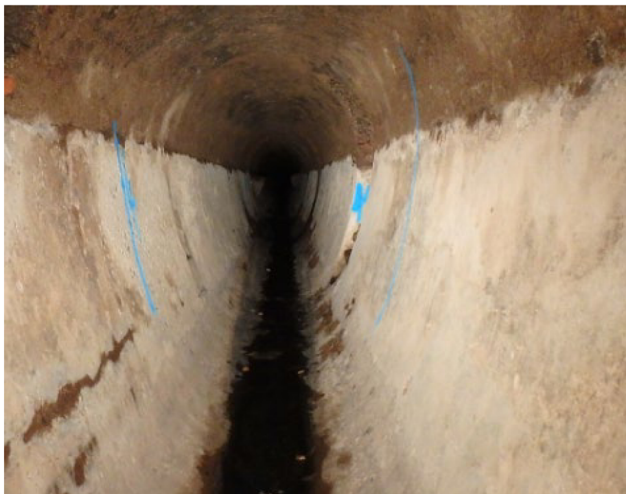
Obr. č. 30: Pohled do stoky v ulici Bolzanova od šachty Š02 směrem po toku (Sismilich, 2018).
