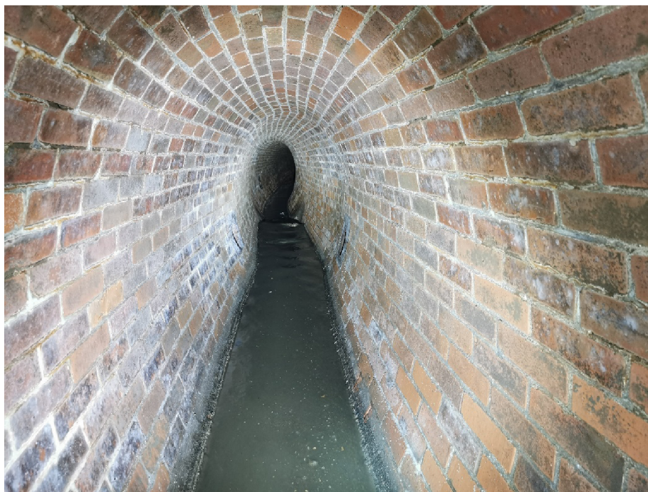
Obr. č. 28: Pohled do stoky v ulici Na Stírce od šachty Š26 směrem po toku (Sismilich, 2021).
