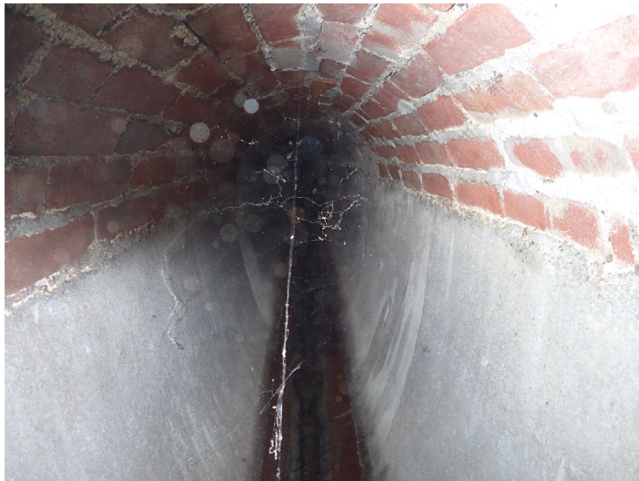
Obr. č. 18: Pohled do stoky v ulici Kladská od šachty Š52 po toku (Sismilich, 2018).
