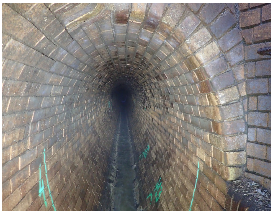
Obr. č. 36: Pohled do stoky v areálu Salabka od Š04 směrem po toku (Sismilich, 2021).
