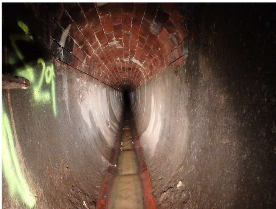
Obr. č. 19: Pohled do stoky v ulici Lužická od šachty Š29 po toku (Sismilich, 2018).
