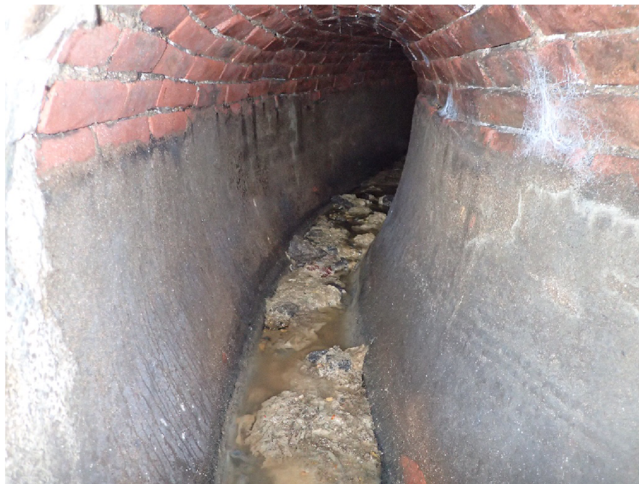
Obr. č. 17: Pohled do stoky v ulici Chodská od Š43 proti toku (Sismilich, 2018).
