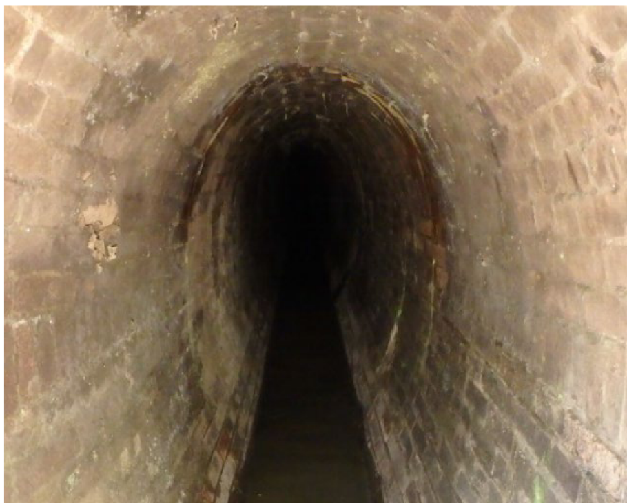
Obr. č. 35: Pohled do stoky v ulici Milosrdných od Š03SK směrem po toku (Sismilich, 2018).
