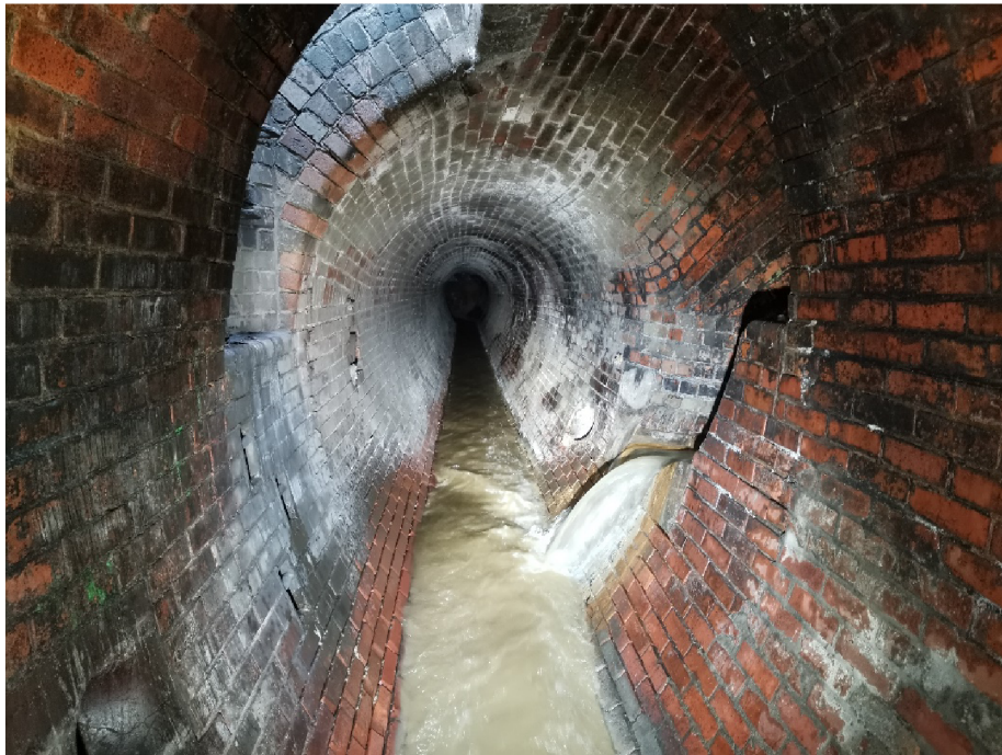
Obr. č. 21: Pohled do stoky v ulici Vinohradská od šachty Š08SK po toku (Sismilich, 2020).
