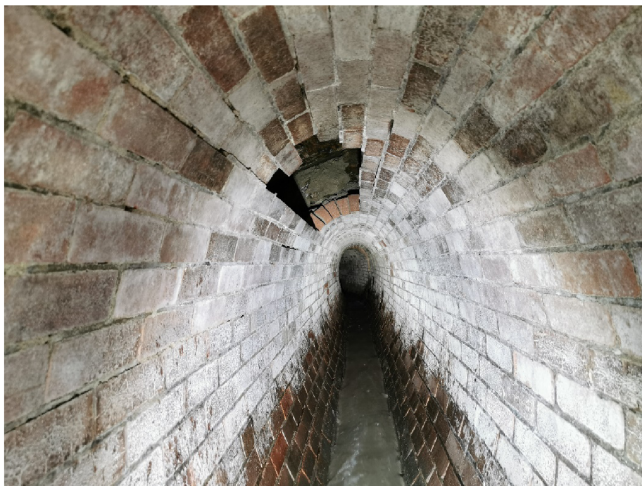
Obr. č. 27: Pohled do stoky v ulici Nad Rokoskou od staničení cca 1615 m směrem po toku (Sismilich, 2021).
