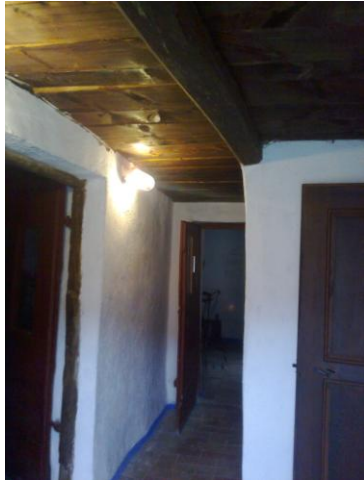
Obr. č. 5 Vstupní prostor domu č. 5
