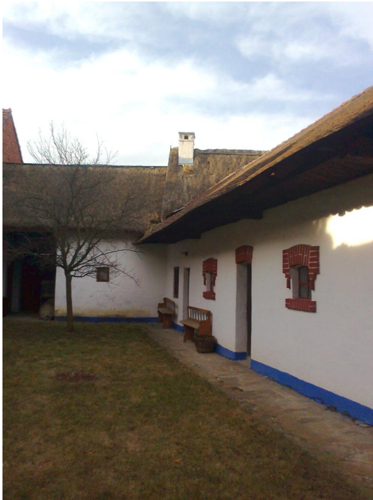
Obr. č. 4 Dvorek domu č. 57
