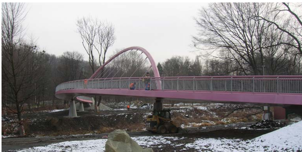
Obr. 1.6 Spřažená portovní lávka pro pěší a cyklisty v Českém a Polském Těšíně – dokončena v květnu r. 2012
