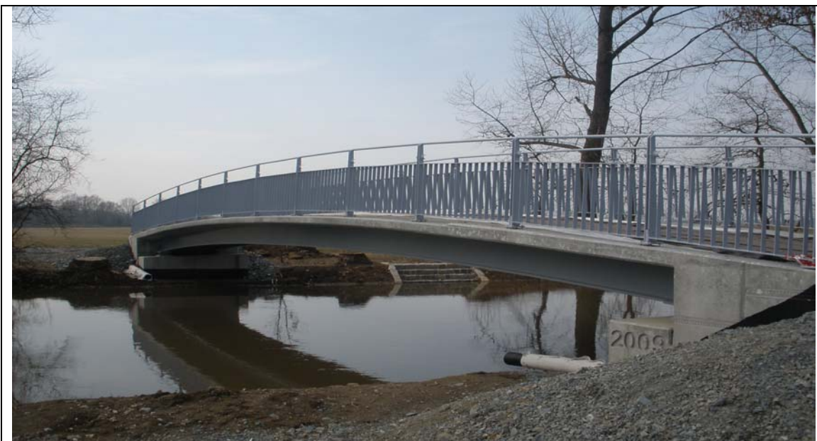
Obr. 1.3 Spřažená ocelobetonová lávka v obci Chomoutov u Olomouce
