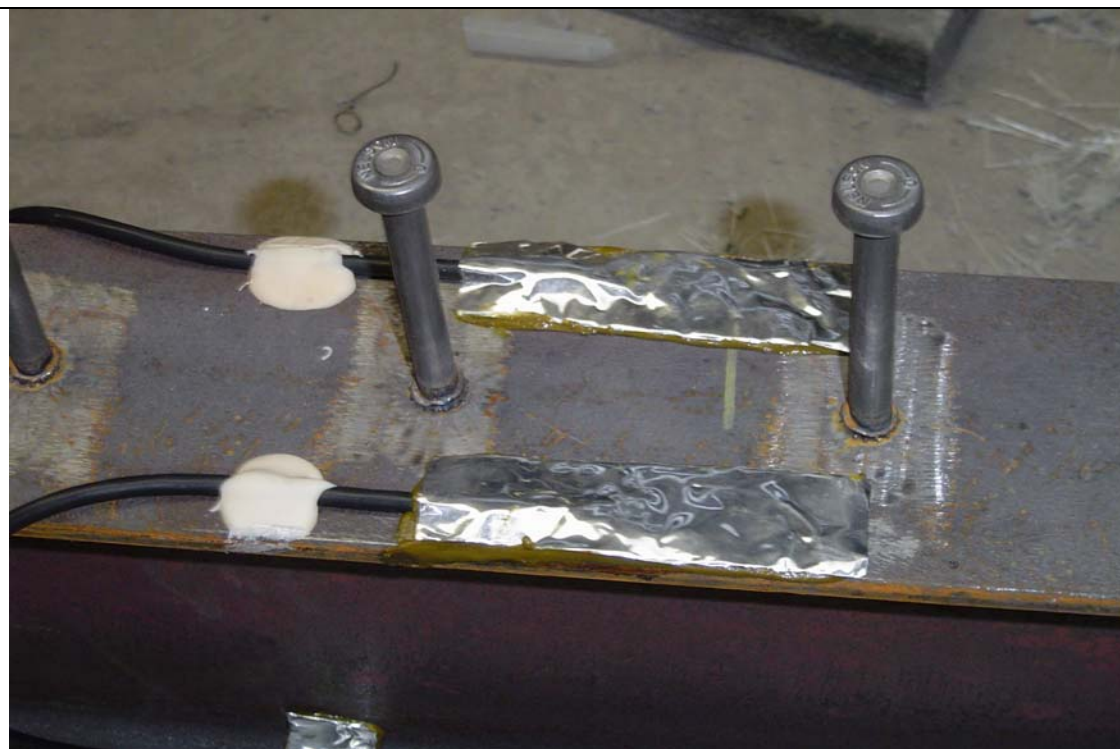
P.31 Příprava tenzometru na IPE nosníku-finální úprava
