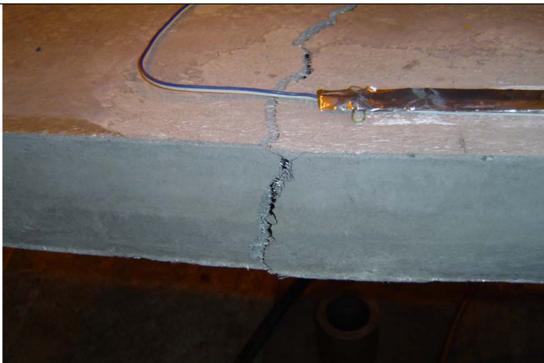
P.32 Magistrální trhlina zkušebního tělesa s rozptýlenou výztuží
