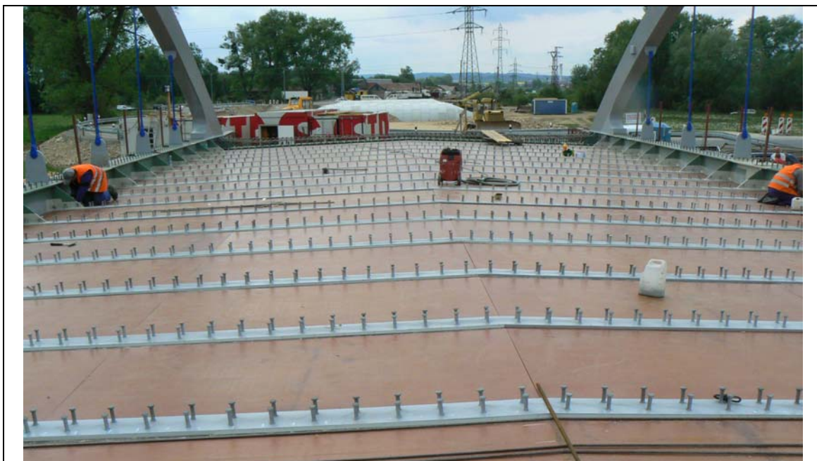
Obr. 1.2 Příprava na betonáž mostovky mostu SO 205 – stavba Mohelnice, Stavenice (2009)
