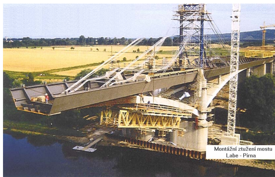
Obr. 1.5 Montážní ztužení mostu Labe u Pirna, Německo
