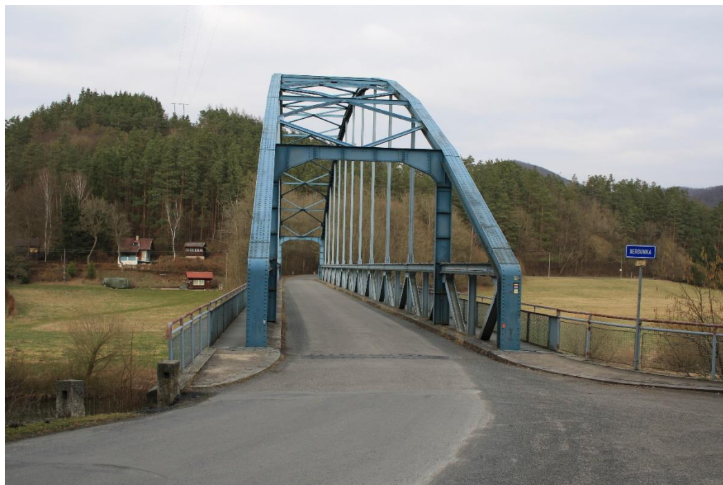
Obr. č. 2 – skryjský most přes řeku Berounku (zdroj: foto autor).
