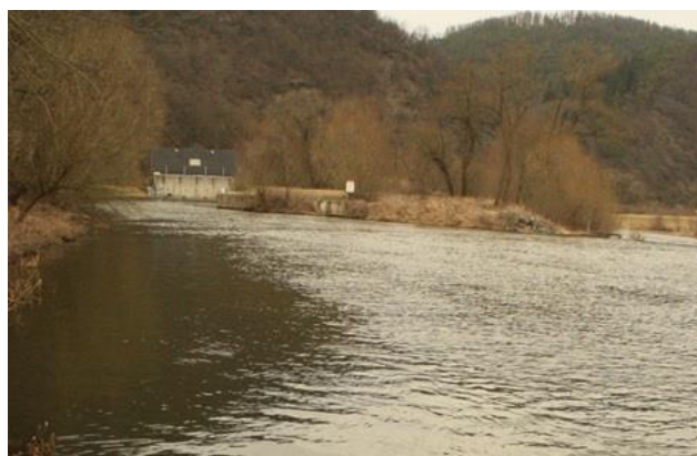
Obr. č. 35 – jez Nezabudický mlýn s malou vodní elektrárnou Nezabudice II (zdroj: foto autor).
