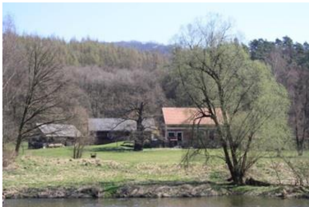
Obr. č. 25 – pohled na Kouřimeckou rybárnu (roubené stavení uprostřed snímku) (zdroj: foto autor).
