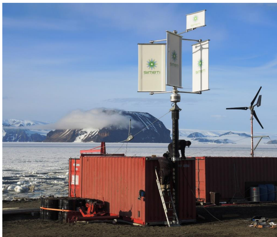
Obr. 2.3: Větrné elektrárny s vertikální (vlevo) a horizontální (vpravo) osou rotace napájející základnu na Antarktidě [15]
