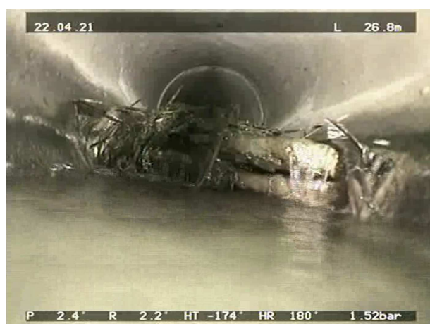
Obrázek 81 BBE- Překážka na toku ve staničení 26,9 m, úsek Š14 A- Š15 A
