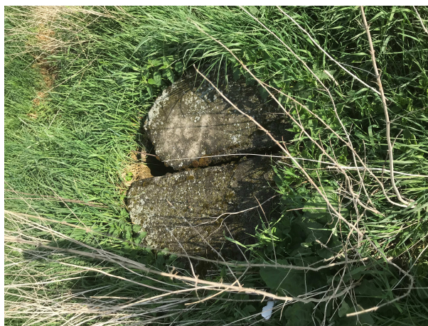
Obrázek 50 Rozbitý poklop Š1 A
