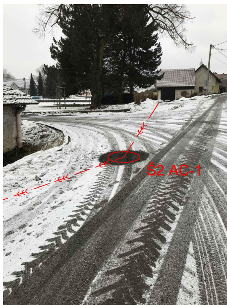
Obrázek 43 Schéma umístění zaasfaltované šachty Š2 AC-1
