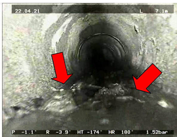
Obrázek 71 BBC- Sedimenty, úsek Š4 AF- Š5 AF
