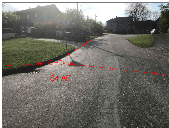
Obrázek 49 Schéma umístění zaasfaltované šachty Š4 AF
