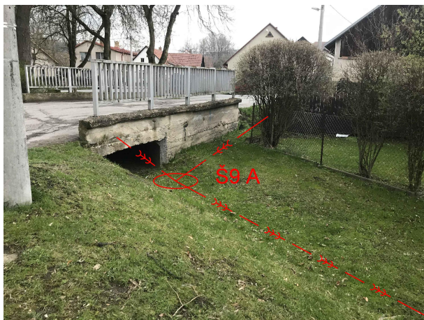
Obrázek 42 Schéma umístění šachty Š9 A pod trávou
