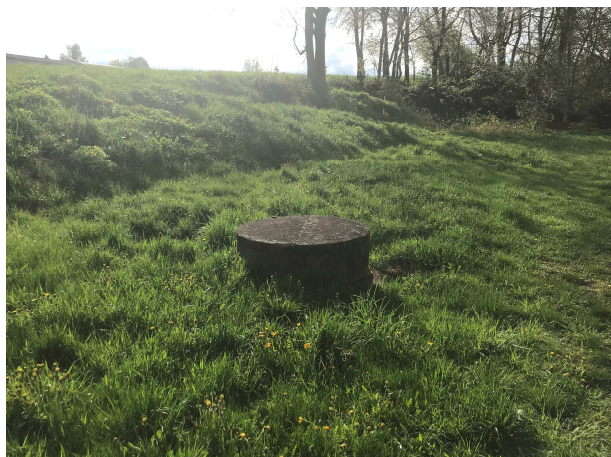
Obrázek 36 Ukázka betonového poklopu DN 1000 na Š2 A
