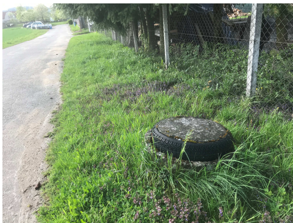
Obrázek 52 Š4 AA Poklop vytvořený z vybetonované pneumatiky
