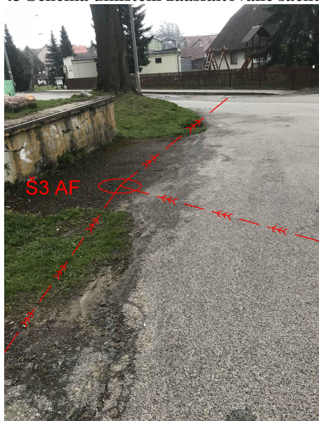
Obrázek 44 Schéma umístění zaasfaltované šachty Š3 AF
