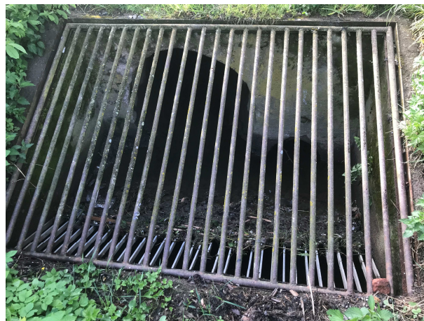
Obrázek 41 Odlehčovací komora na stoce A
