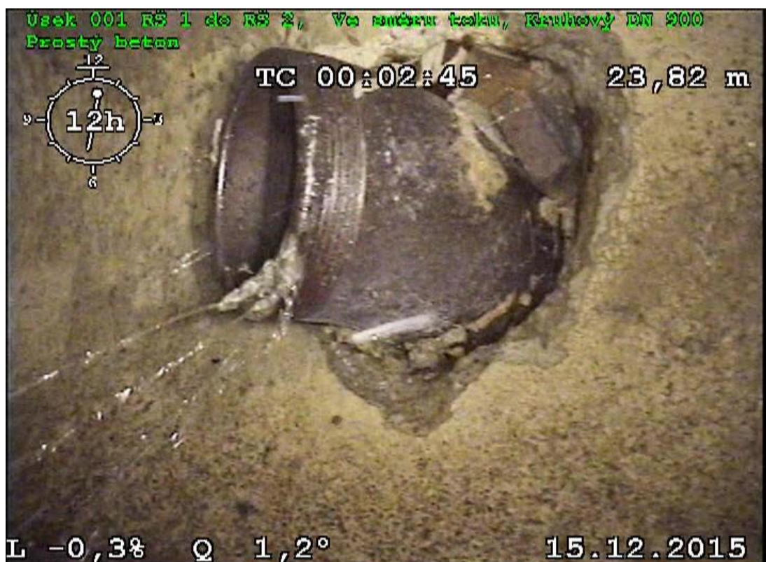
Obrázek 8.4 – Úsek Š1 – Š2, celý úsek, přesazené přípojky KT 150 – BCAEA, přesazení cca 10% BAG
