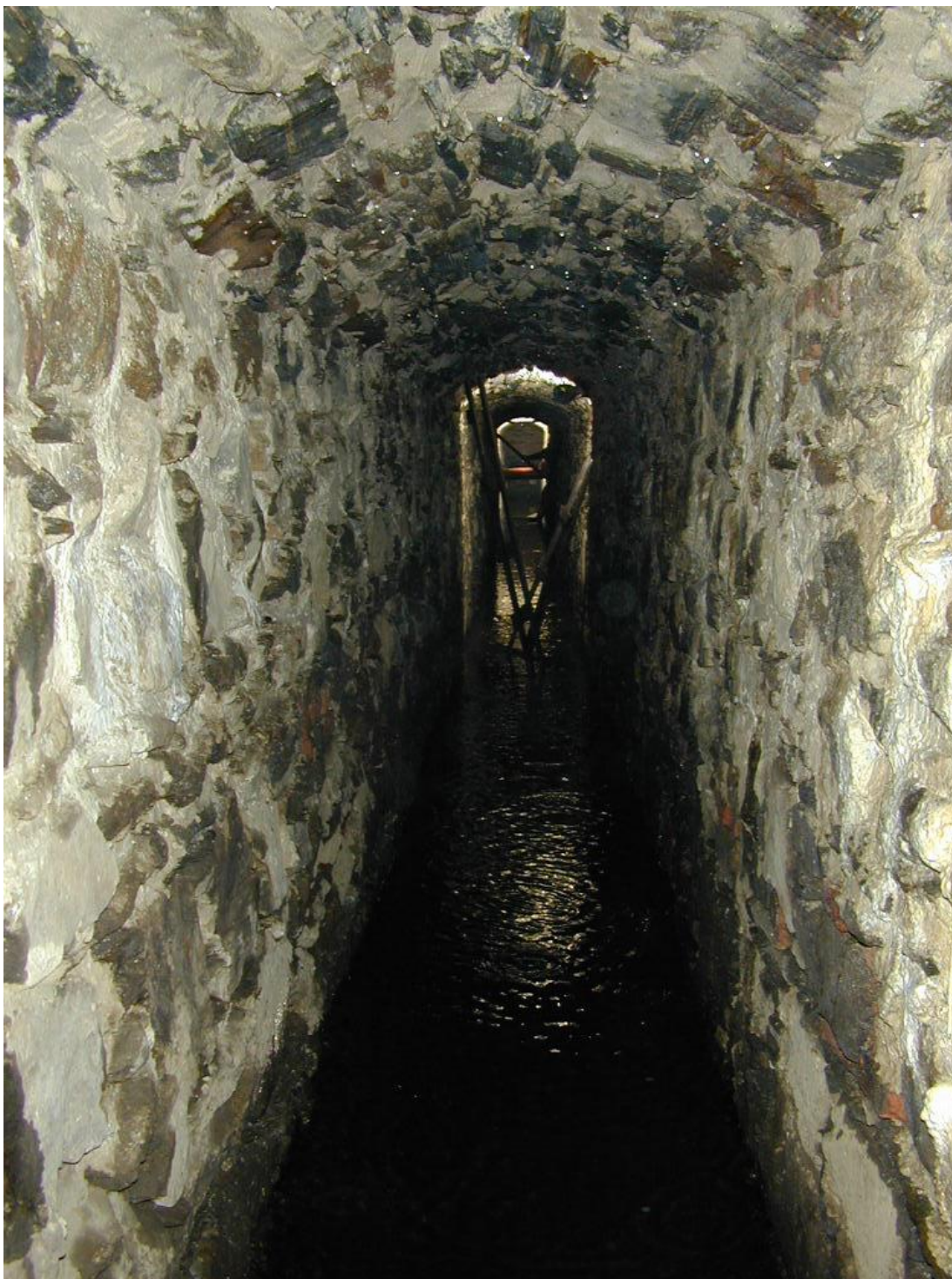
Obrázek 5.3 – Středověká odvodňovací stoka v klášteře v Teplé (Zdroj: Vlastní)
