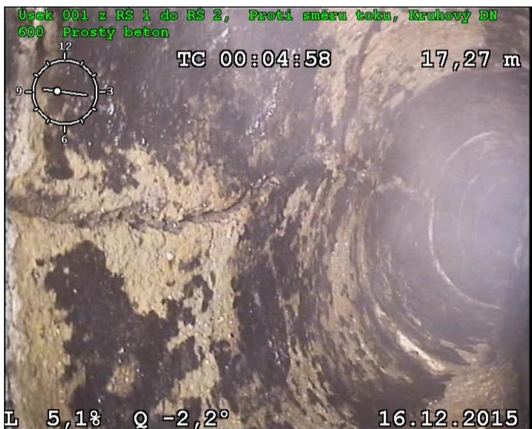
Obrázek 8.8 – Úsek Š1 – Š2, otevřené praskliny, celý úsek - BABCA
