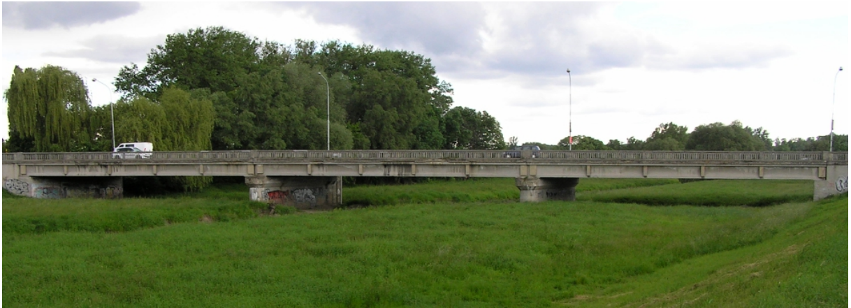
Obr. 4.4: Most v Poštorné (Odlehčovací rameno Dyje, km 2,707) 90
