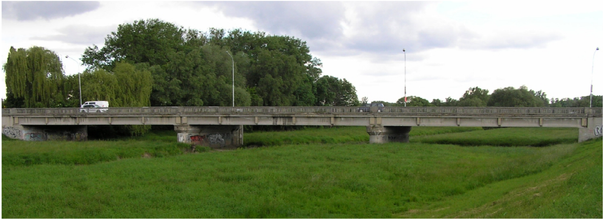
Obr. 4.4: Most v Poštorné (Odlehčovací rameno Dyje, km 2,707) 90
