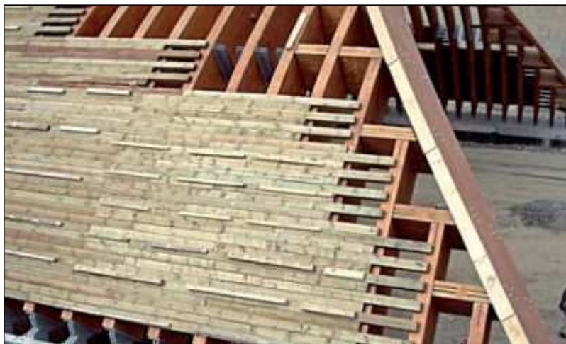
Obr. 8-4 Montáž záklopu z řeziva
