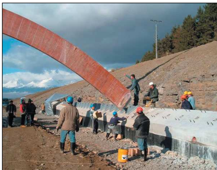
Obr. 8-14 Montáž nosníků obdobného ekoduktu na Slovensku
