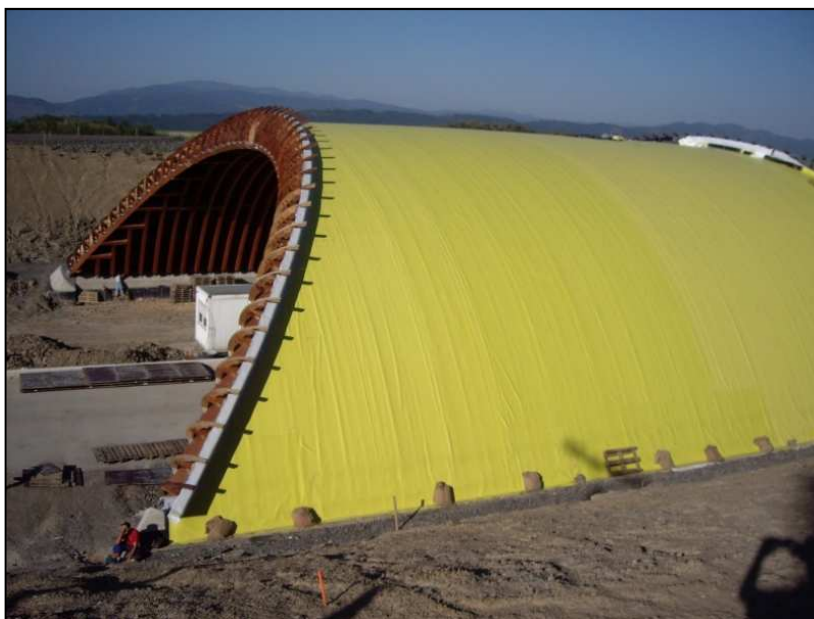
Obr. 8-17 Izolace obdobného ekoduktu na Slovensku
