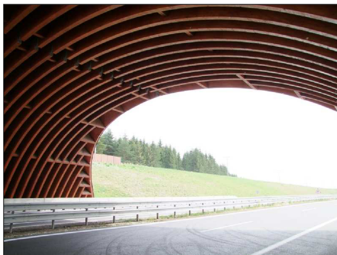
Obr. 8-15 Pohled z komunikace u ekoduktu na Slovensku
