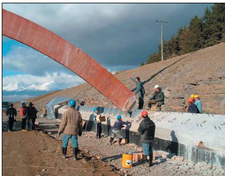
Obr. 8-14 Montáž nosníků obdobného ekoduktu na Slovensku
