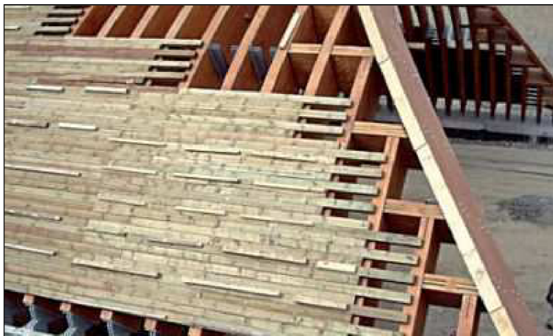
Obr. 8-4 Montáž záklopu z řeziva
