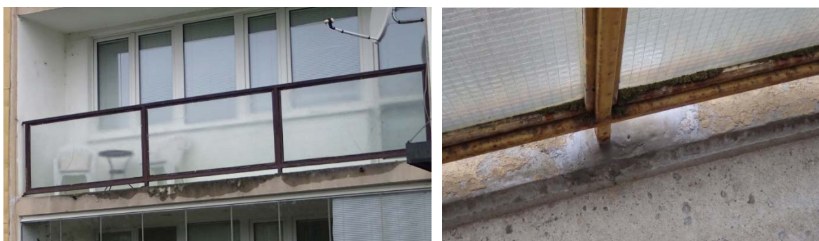
Obr. 15: Stávající stav zábradlí lodžie
