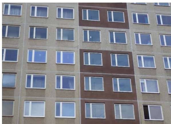
Obr. 14: Severní část fasády
