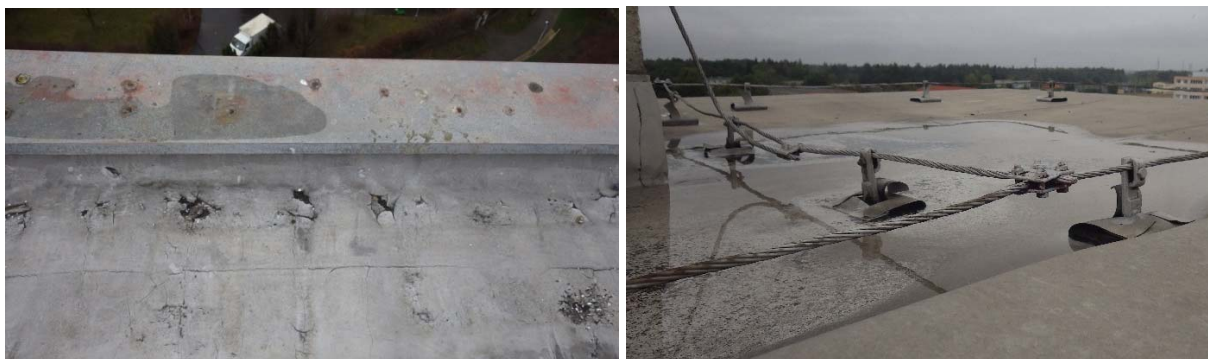
Obr. 16: Stávající stav střešního pláště
