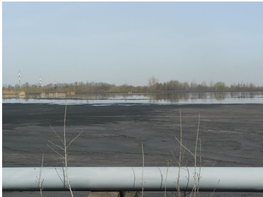
Příloha č. 19 – Odkalovací nádrž Heřmanice (zdroj: autor)
