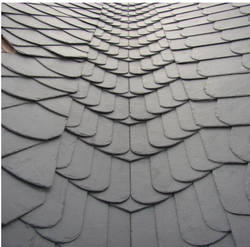
Obrázek 11: úžlabí vyskládáno z břidlicové krytiny
