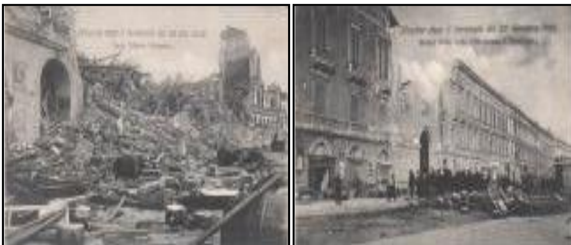
1. Ukázka poničení budov po zemětřesení v Itálii - Messina, 28. 12. 1908 35
