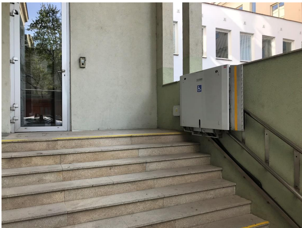
Obrázek 24 Invalidní plošina – vstup do budovy
