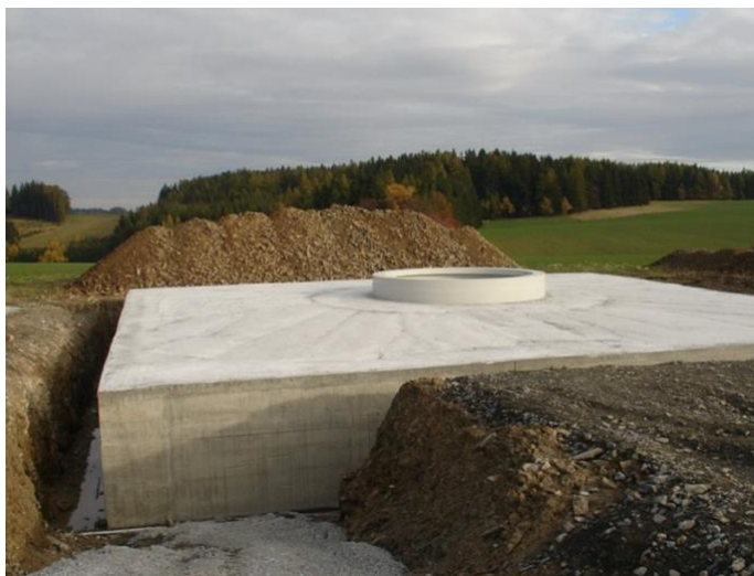
Obrázek 9: Pohled na hotový železobetonový základ větrné elektrárny (Česká společnost pro větrnou energii ©2021b)
