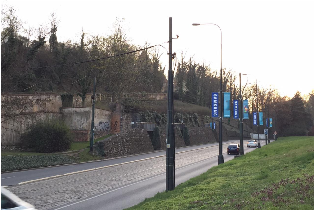
Obr. č. 6: Rušivé elementy, Malostranská, 2015 (foto vlastní)
