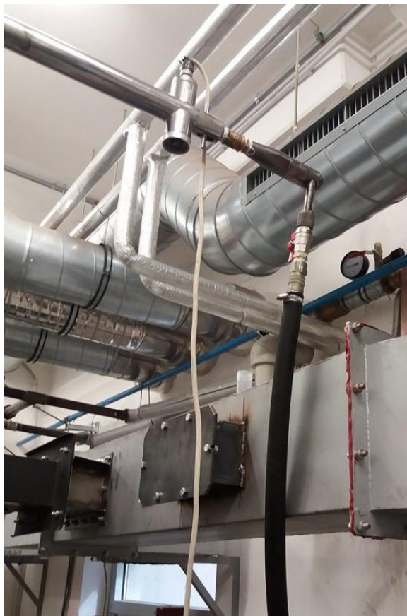
Obrázek 34 Zachycovač 2 (za cyklonem, cylindrický filtr)
