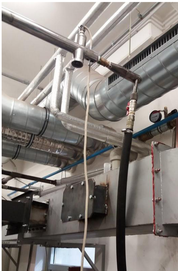
Obrázek 34 Zachycovač 2 (za cyklonem, cylindrický filtr)
