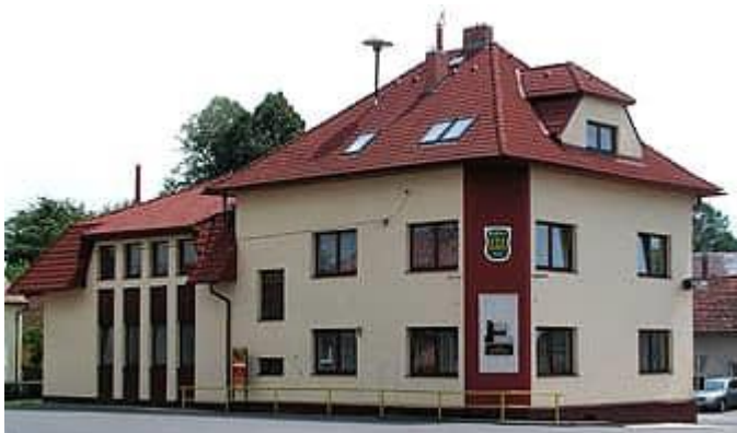
Obrázek 16: Sál obecního úřadu v levém podkroví budovy (vlastní zpracování).
