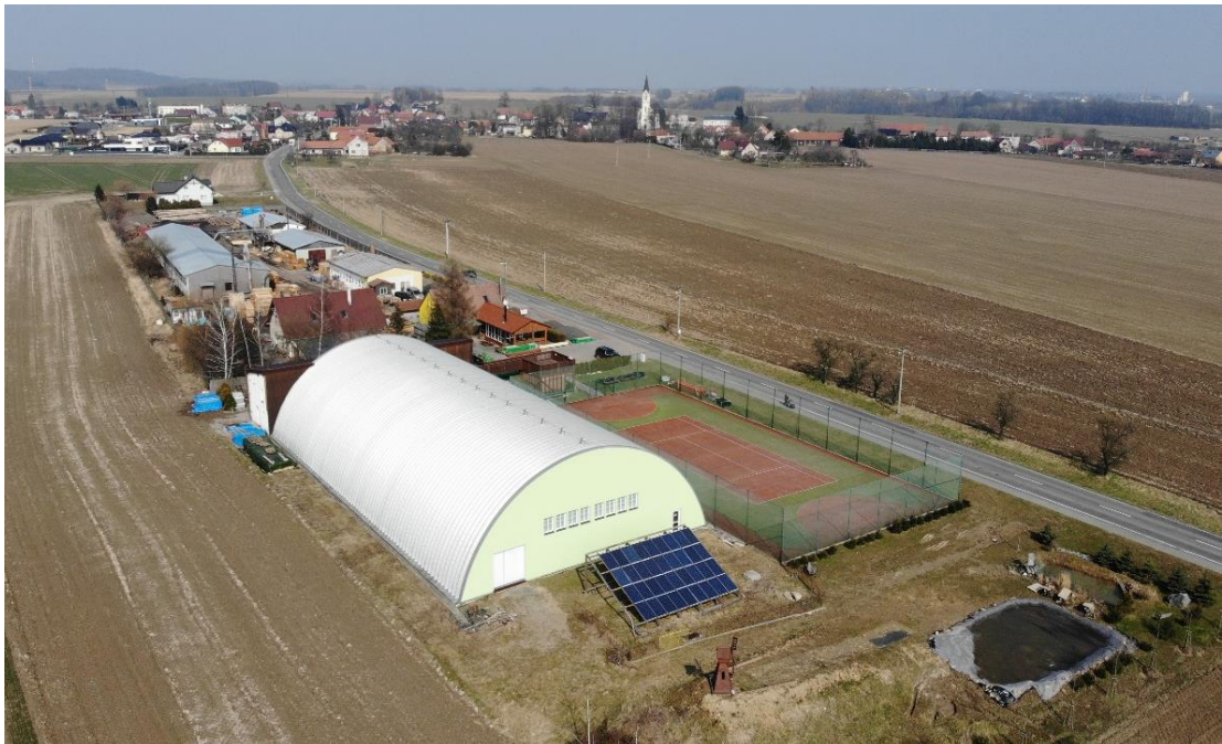
Obrázek 19: Víceúčelová sportovní hala a víceúčelové sportovní hřiště (vlastní zpracování).
