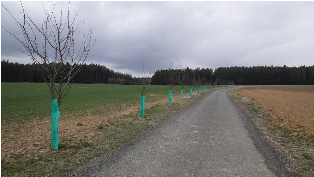
Obr. č. 22 Povrch cesty tvoří penetrační makadam hrubý, po levé straně liniová zeleň z ovocných stromů tvoří krajínotvorný prvek, datum expozice: 2015-04-06
