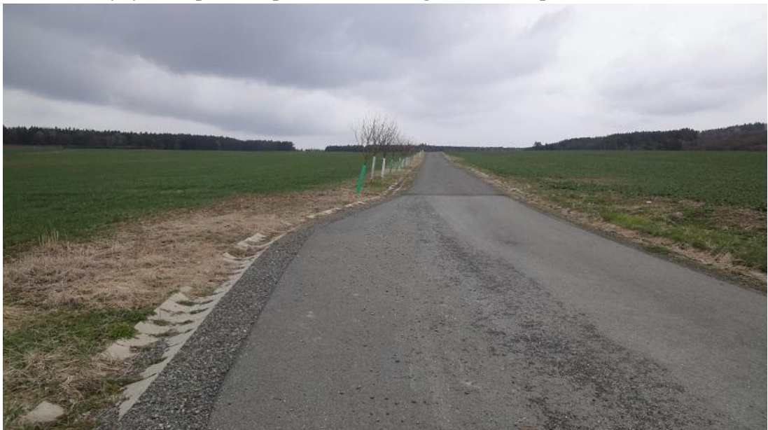
Obr. č. 23 Výhybna a přechod povrchů, vlevo rigol, datum expozice: 2015-04-06
