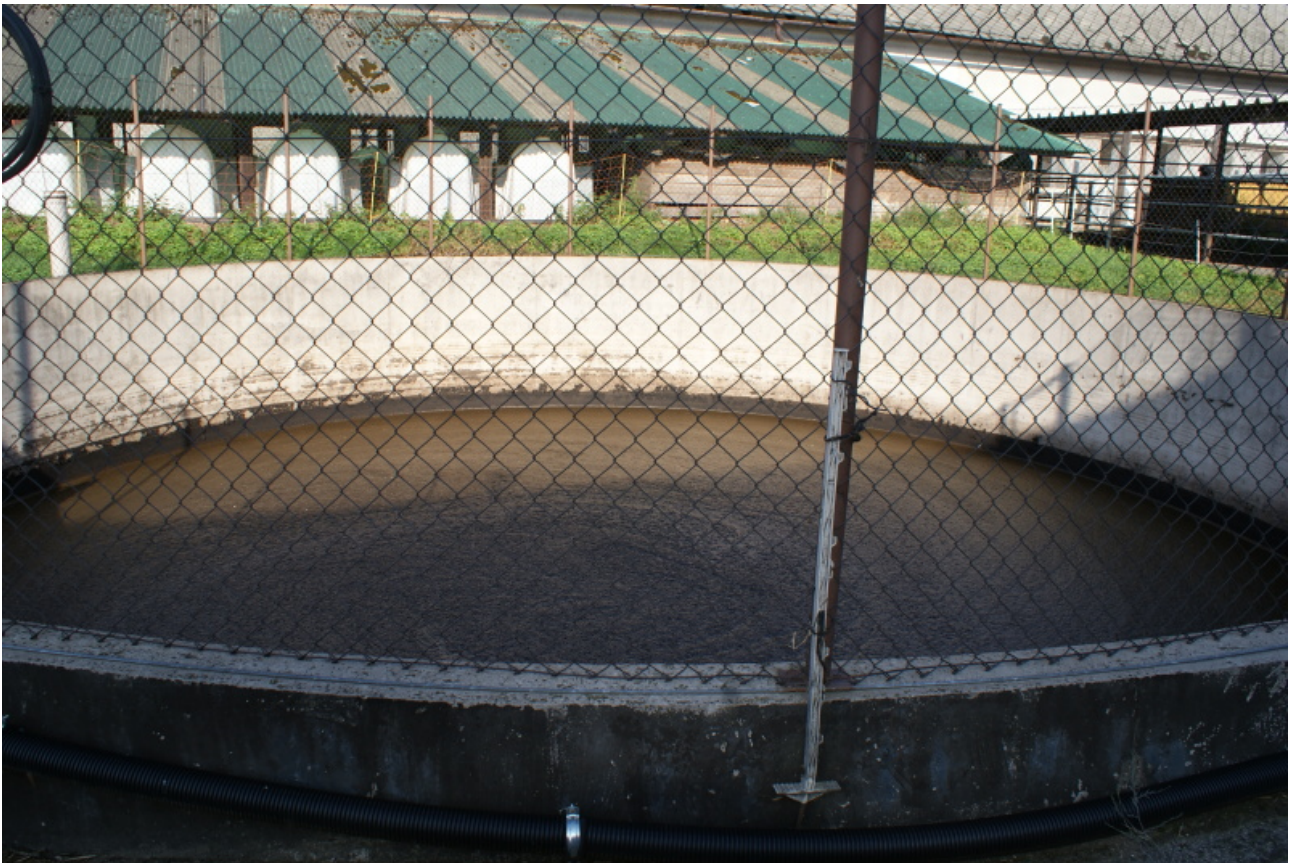
Obr. 10 Přípravná nádrž na hovězí kejdu
