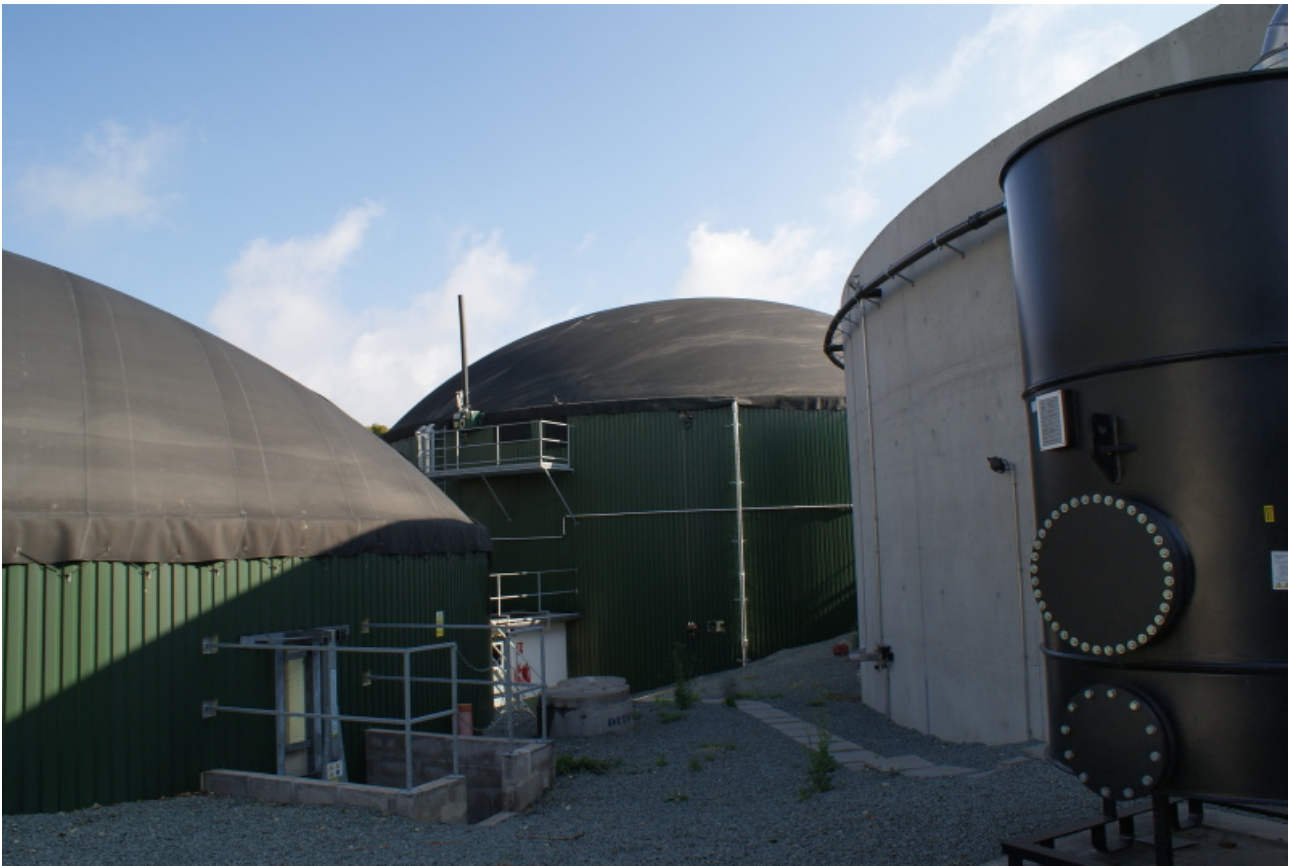
Obr. 23 Skladovací nádrž s bezpečnostním ventilem
