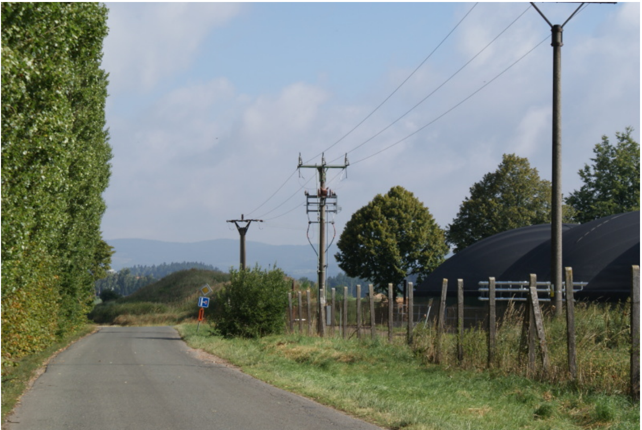
Obr. 34 Připojení bioplynové stanice na vysoké napětí
