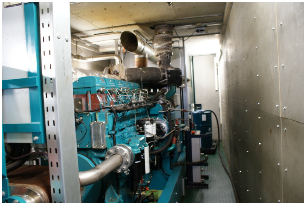
Obr. 30 Kogenerační jednotka Schnell - motor kogenerační jednotky
