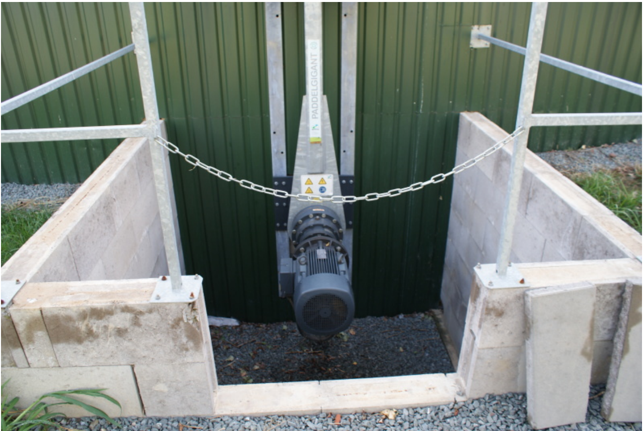
Obr. 15 Elektromotor lopatkového míchadla
