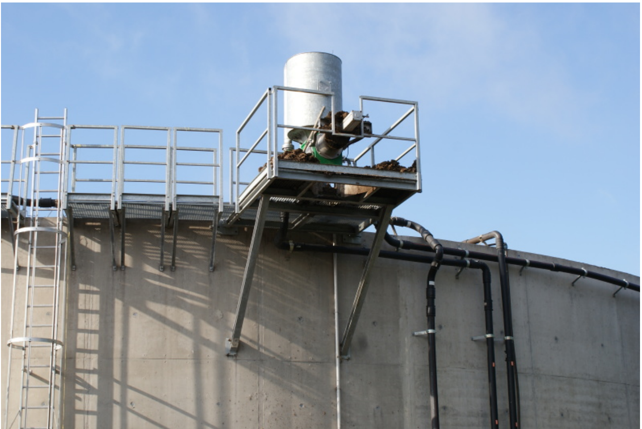
Obr. 37 Zařízení na oddělení pevné složky substrátu od kapalné
