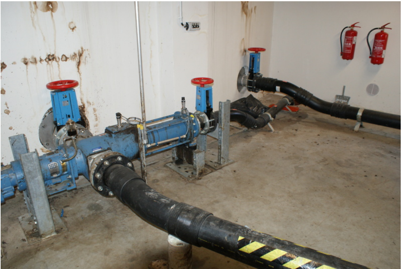
Obr. 19 Potrubí na substrát
