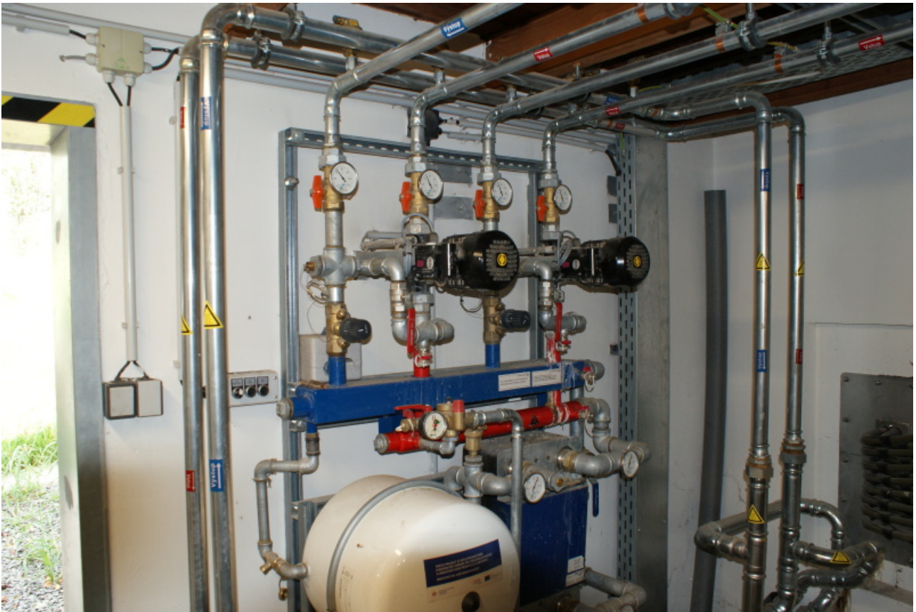
Obr. 16 Regulační zařízení pro ohřev fermentoru
