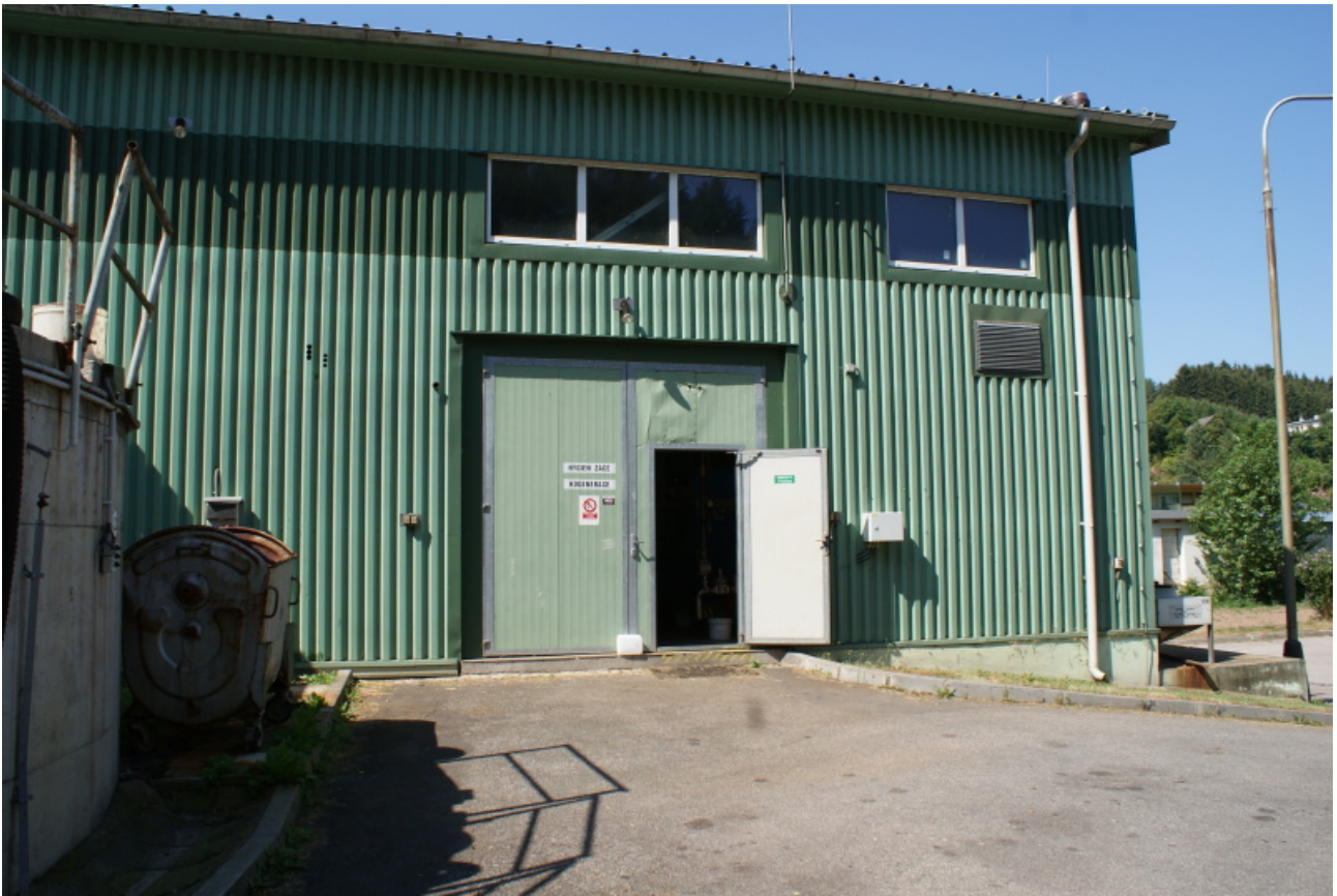
Obr. 22 Vstup ke kogenerační jednotce v hlavní budově bioplynové stanice
