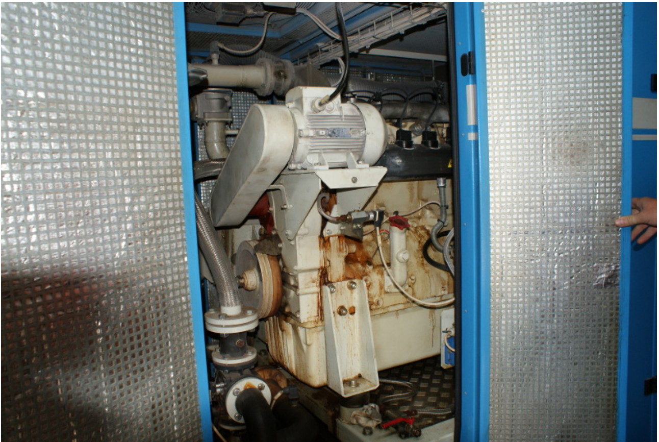
Obr. 24 Vnitřní dispozice kogenerační jednotky
