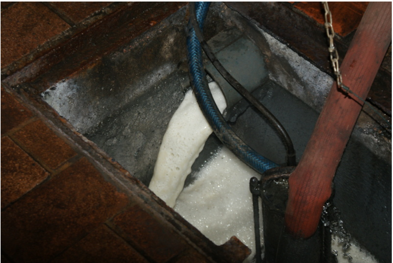
Obr. 37 Kapalná složka je odváděna do vedlejší ČOV
