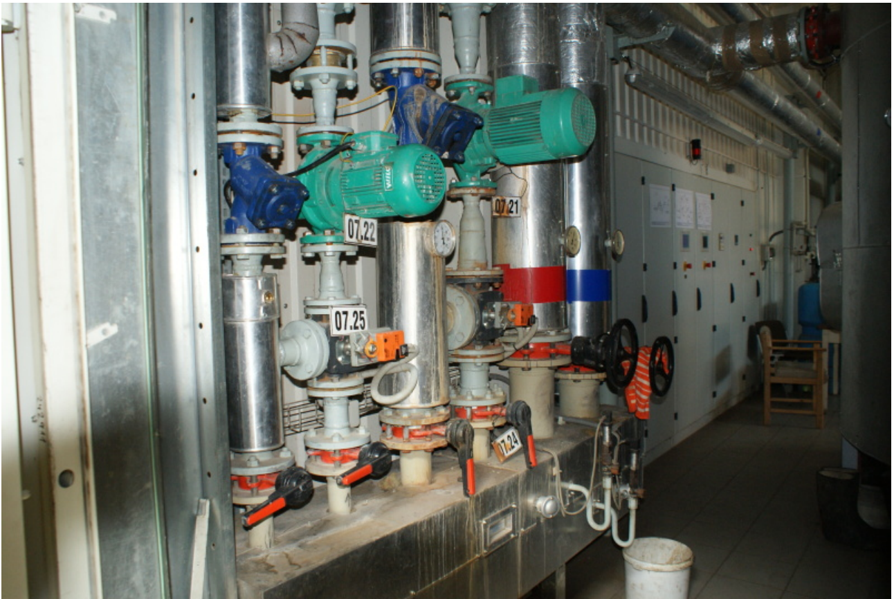
Obr. 18 Čerpadla pro výměnu obsahu v pasterizačních nádobách
