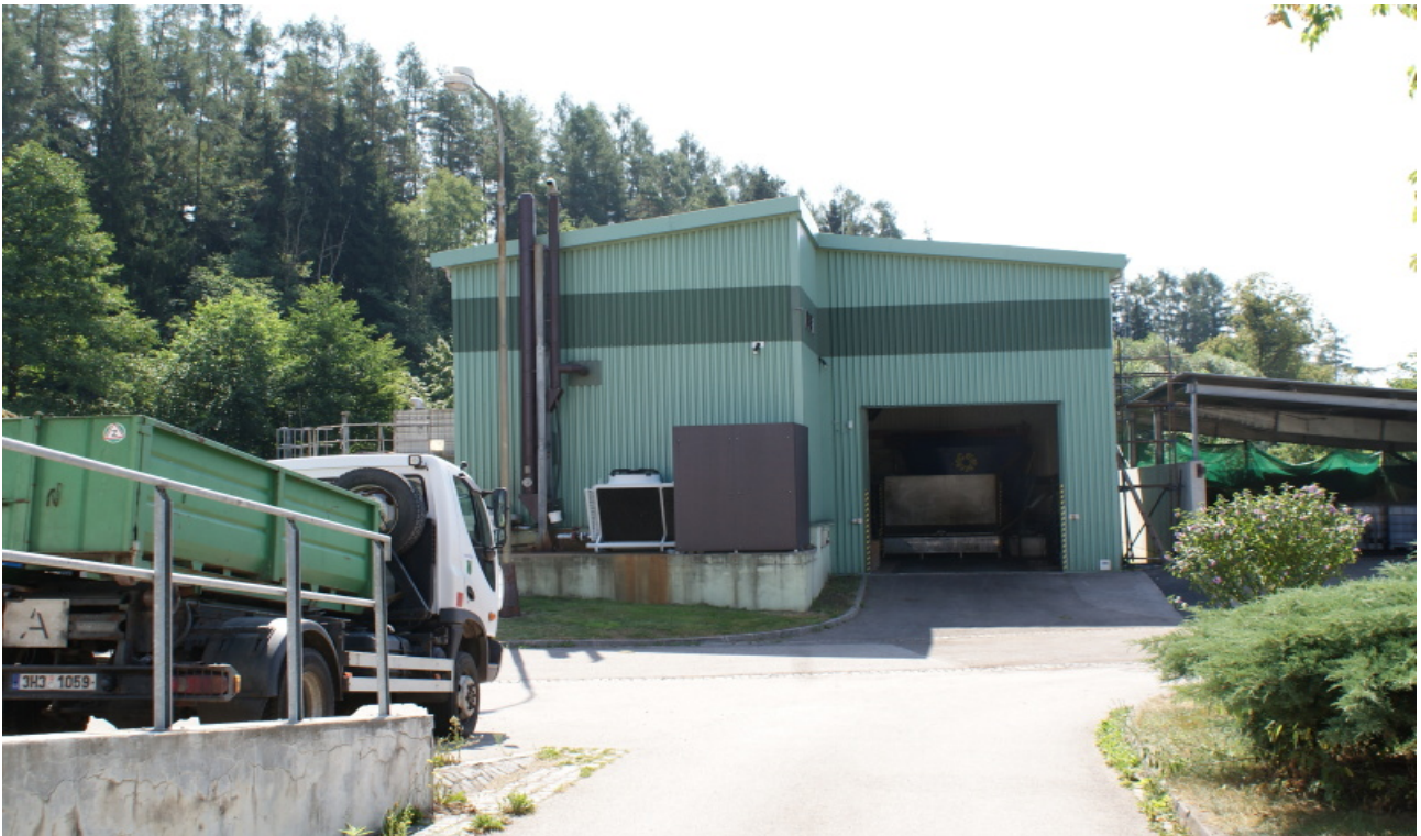
Obr. 3 Pohled na hlavní budovu bioplynové stanice
