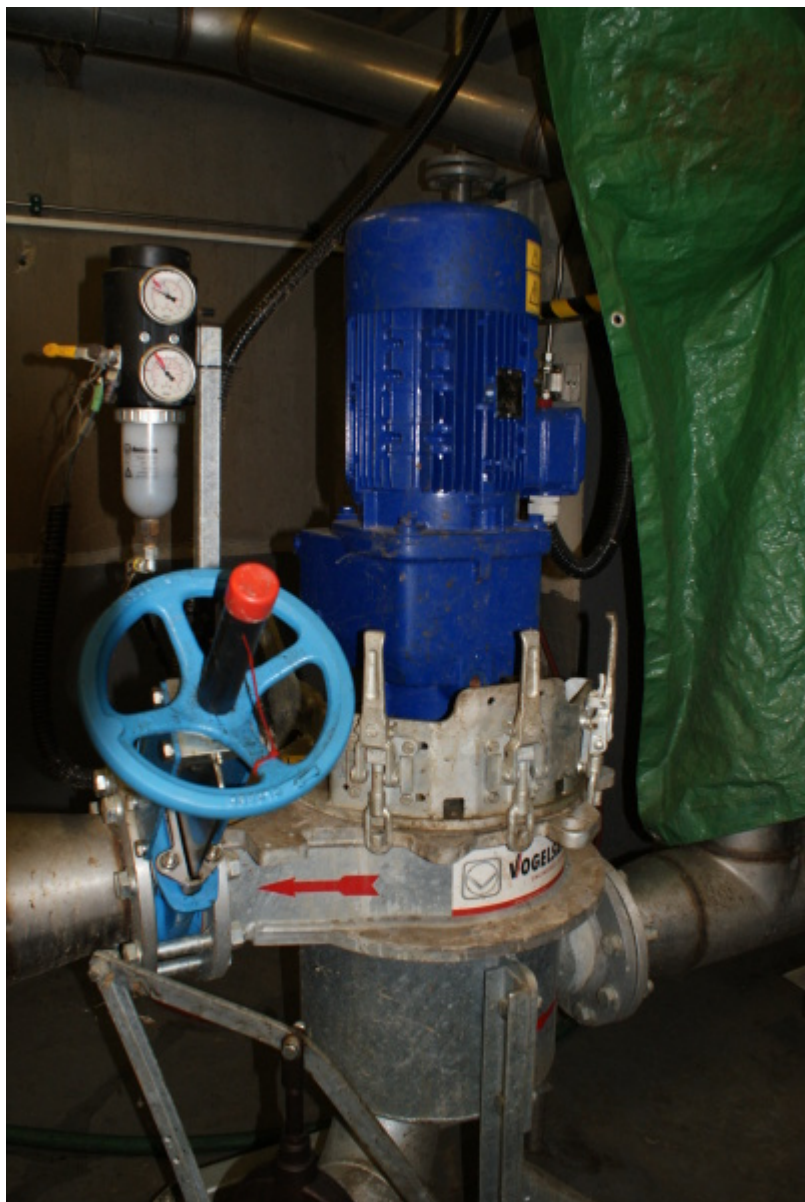
Obr. 13 Mlýnek fy VOGELSANG na drcení pevných částic v tekuté složce odpadu
