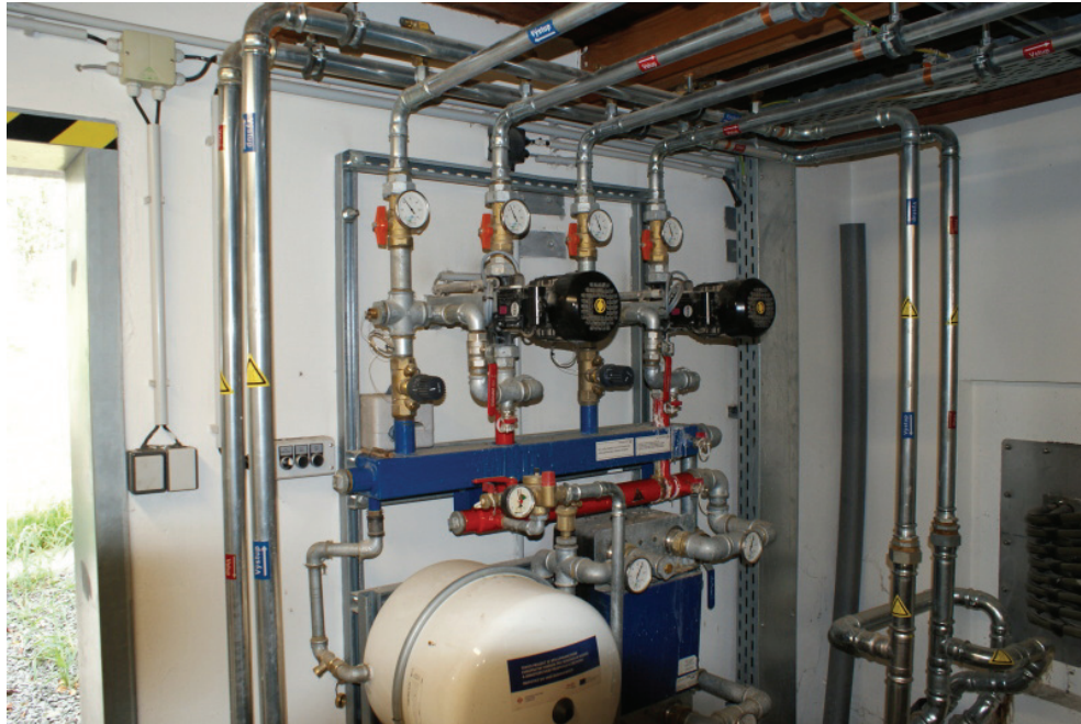
Obr. 4 Regulační zařízení pro ohřev fermentoru
