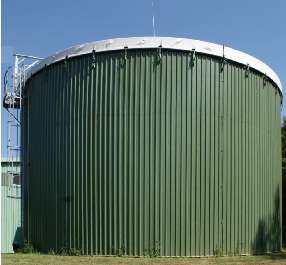
Obr. 19 Vertikální typ fermentoru bioplynové stanice Úpice
