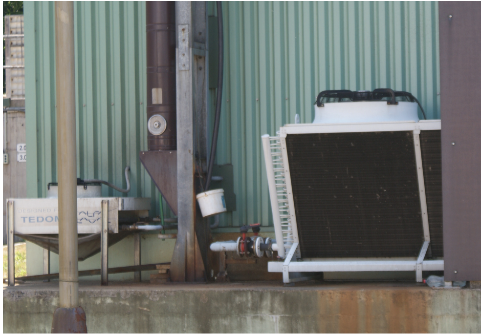
Obr. 37 Chlazení kogenerační jednotky
