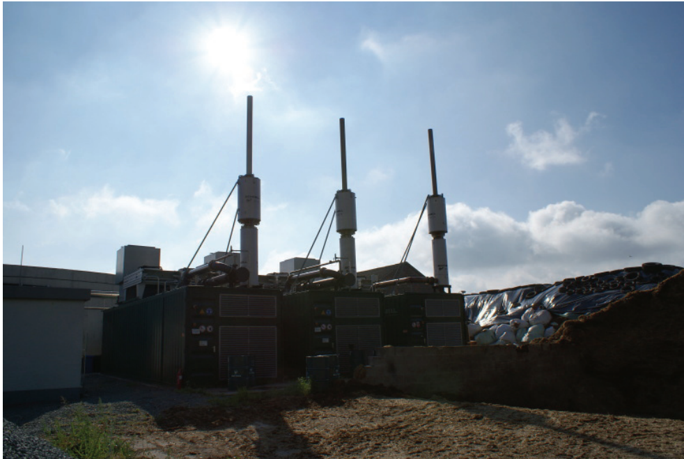
Obr. 38 Kogenerační jednotky značky Schnell
