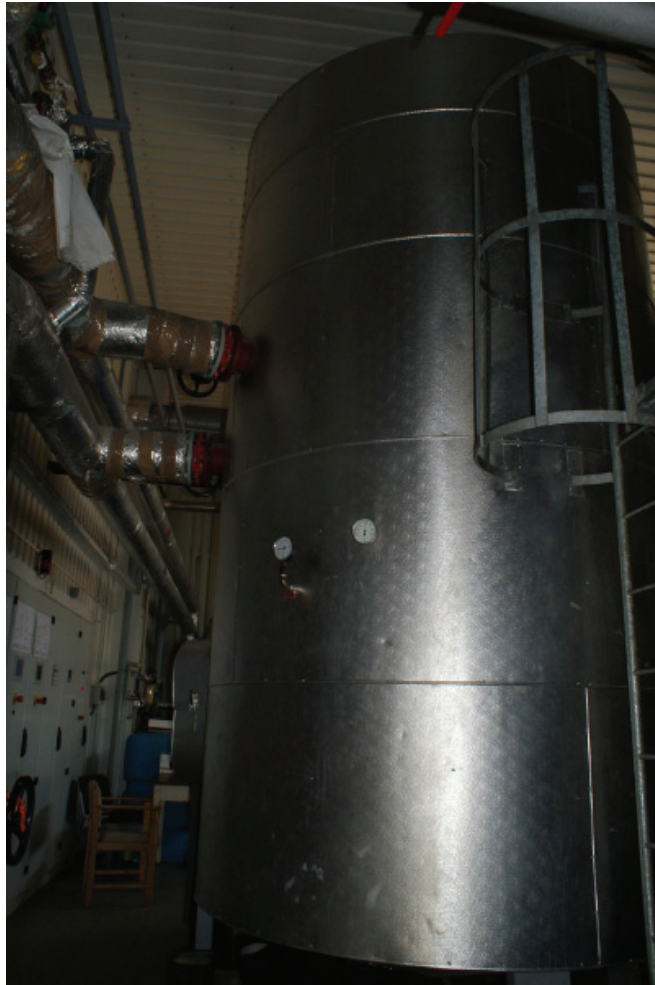
Obr. 41 Pasterizační nádoba hygienizační linky BPS Úpice
