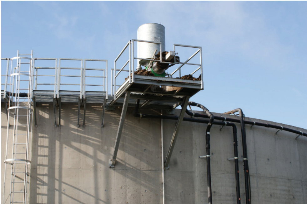
Obr. 43 Zařízení na oddělení pevné složky substrátu od kapalné
