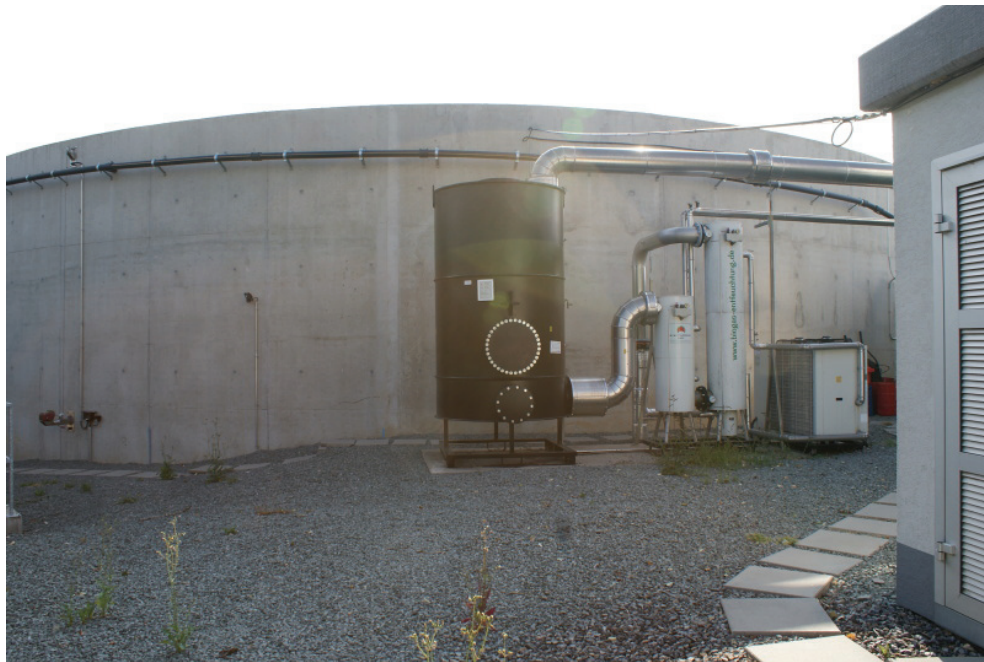
Obr. 15 Filtr s dřevěným uhlím
