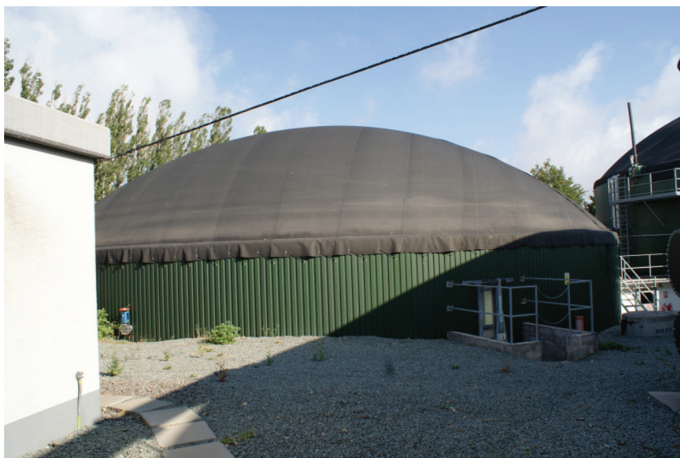
Obr. 20 Vertikální typ dofermentoru bioplynové stanice Olešnice
