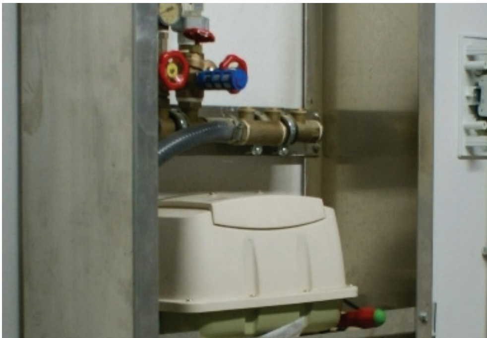
Obr. 34 Membránové čerpadlo
