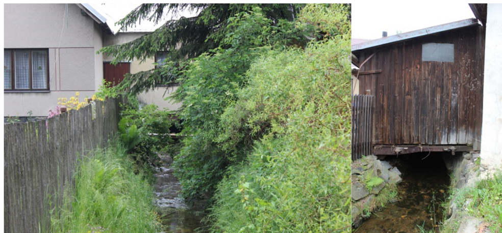
Obr. 3.7: Křížení toku stavbou - ř. km 0,0547 - 0,0684
