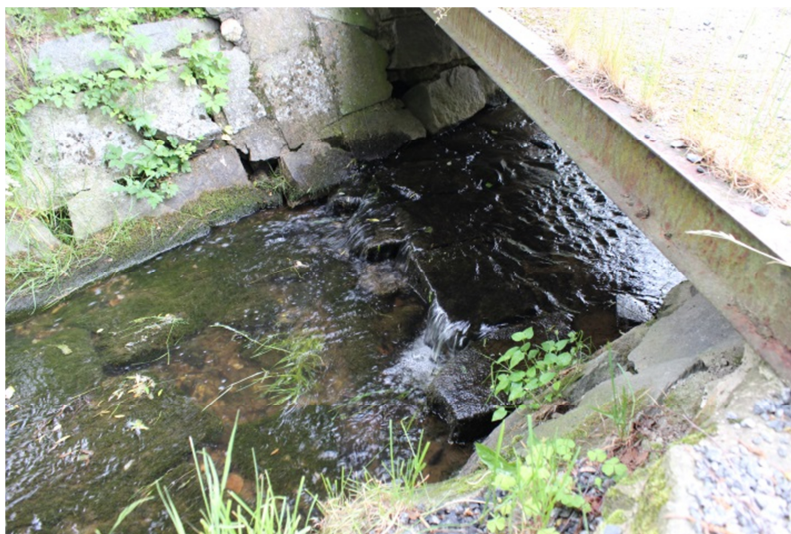
Obr. 3.3: Spádový stupeň - ř. km 0,0210
