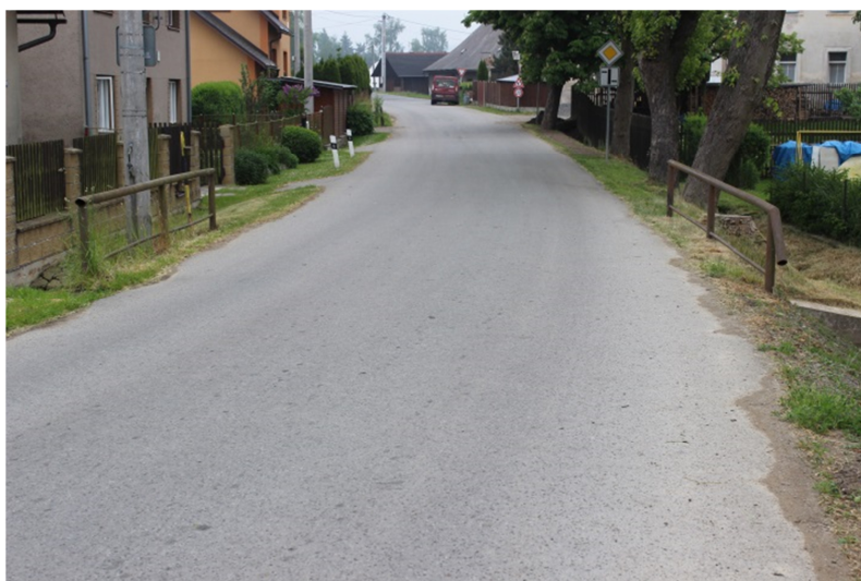
Obr. 3.12: Silniční most M2 - ř. km 0,18615
