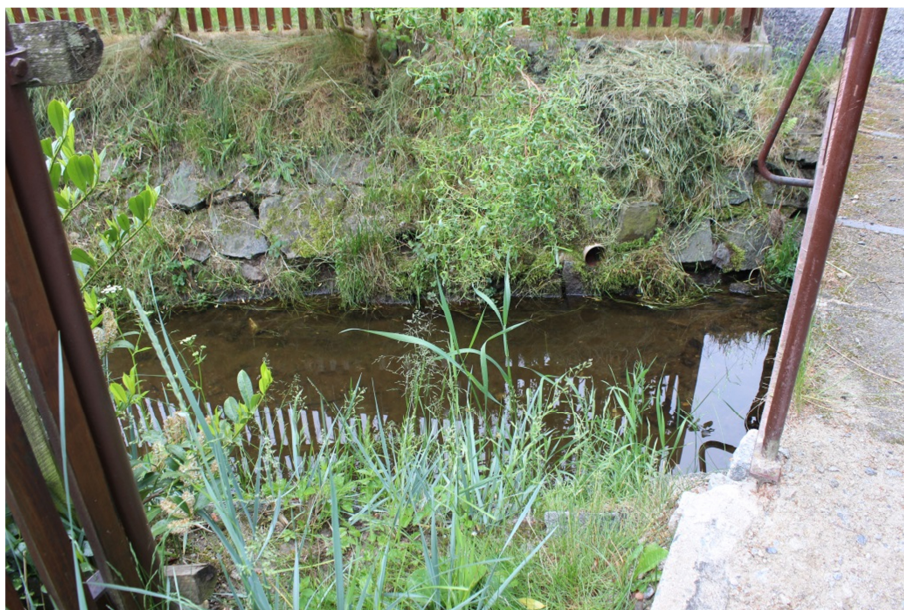
Obr. 3.1: Ukázka kamenné rovnániny
