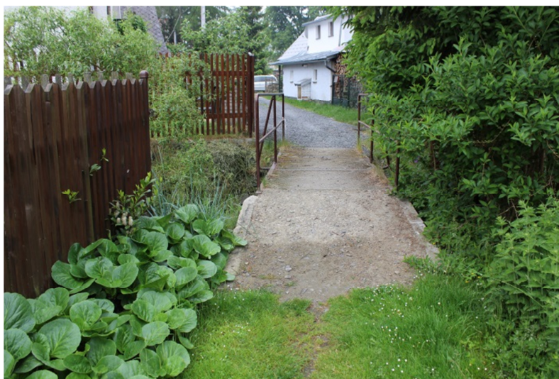
Obr. 3.6: Lávka pro pěší L1 - ř. km 0,0212
