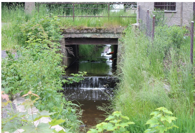
Obr. 3.9: Silniční most M1 - ř. km 0,1097
