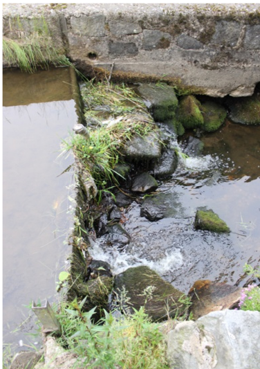
Obr. 3.5: Spádový stupeň - ř. km 0,1541
