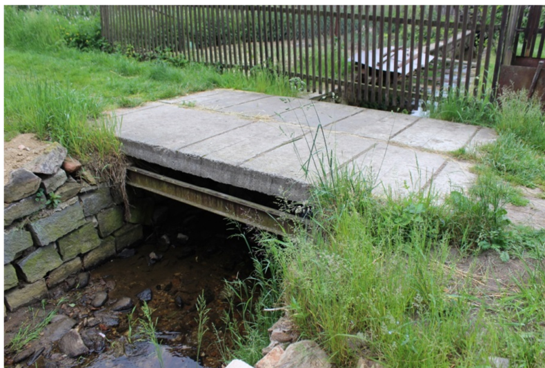
Obr. 3.13: Železobetonové panely M3 - ř. km 0,31125
