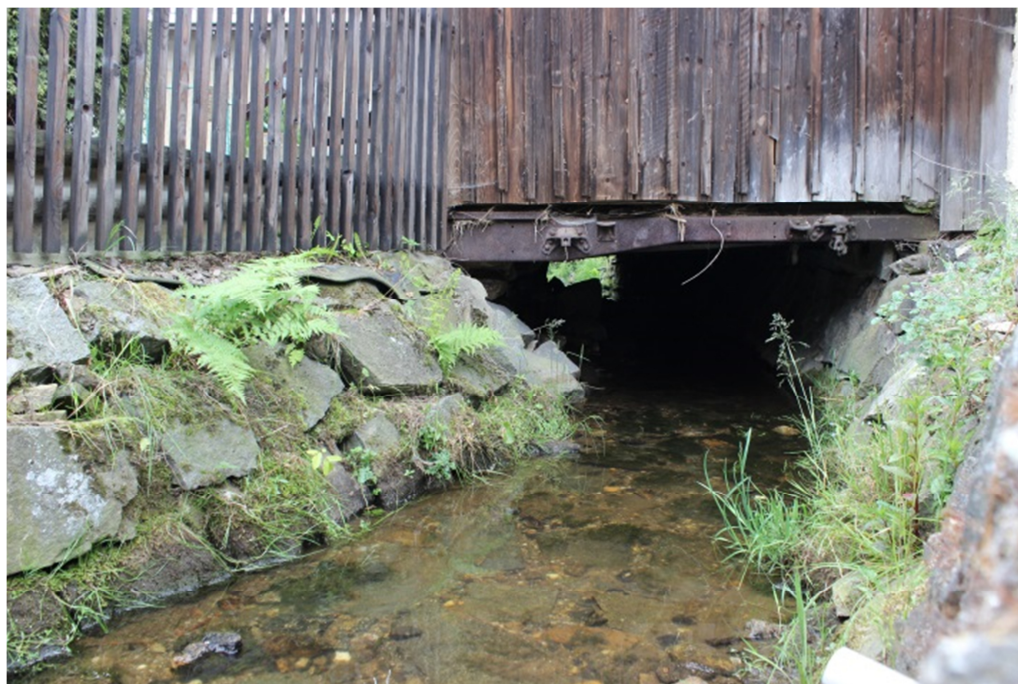
Obr. 3.8: Detail křížení toku se stavbou
