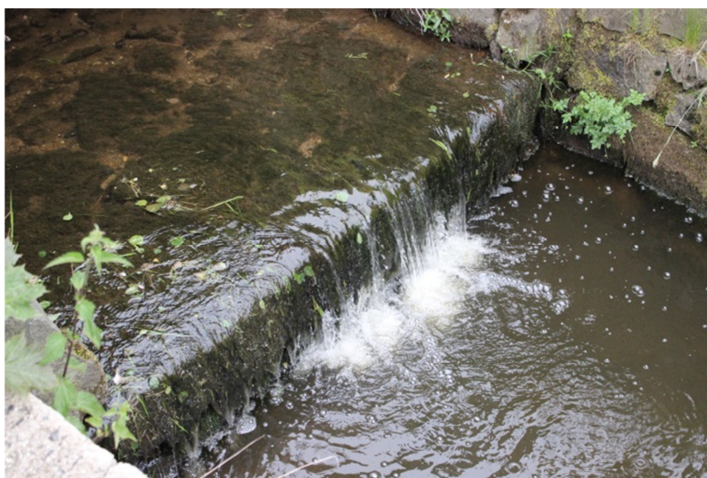
Obr. 3.4: Spádový stupeň - ř. km 0,1054
