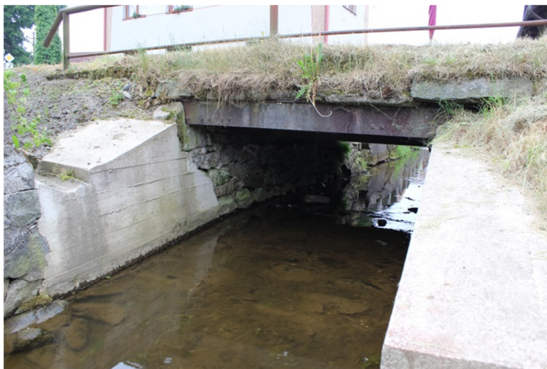
Obr. 3.11: Silniční most M2 - ř. km 0,18615
