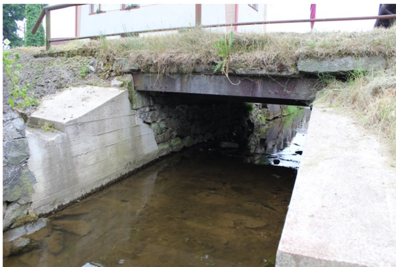
Obr. 3.11: Silniční most M2 - ř. km 0,18615
