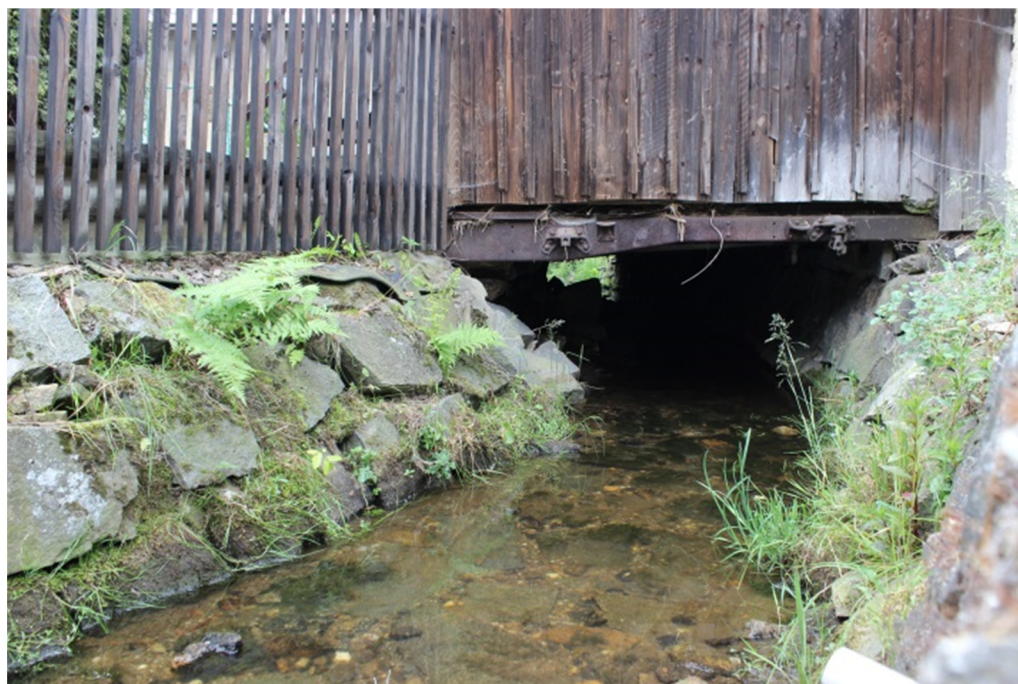
Obr. 3.8: Detail křížení toku se stavbou
