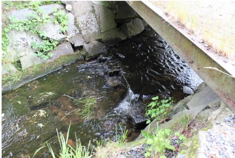
Obr. 3.3: Spádový stupeň - ř. km 0,0210
