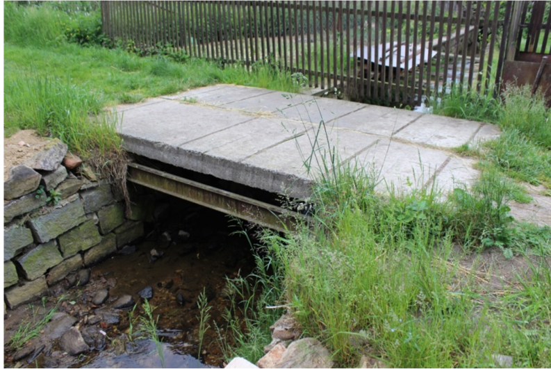
Obr. 3.13: Železobetonové panely M3 - ř. km 0,31125
