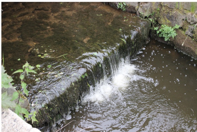
Obr. 3.4: Spádový stupeň - ř. km 0,1054
