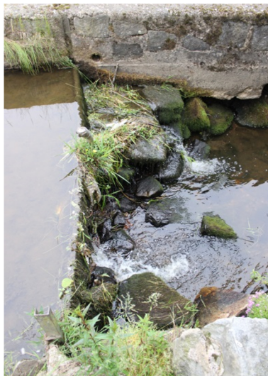
Obr. 3.5: Spádový stupeň - ř. km 0,1541
