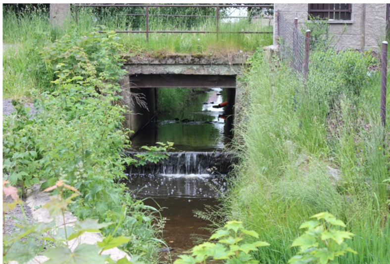
Obr. 3.9: Silniční most M1 - ř. km 0,1097
