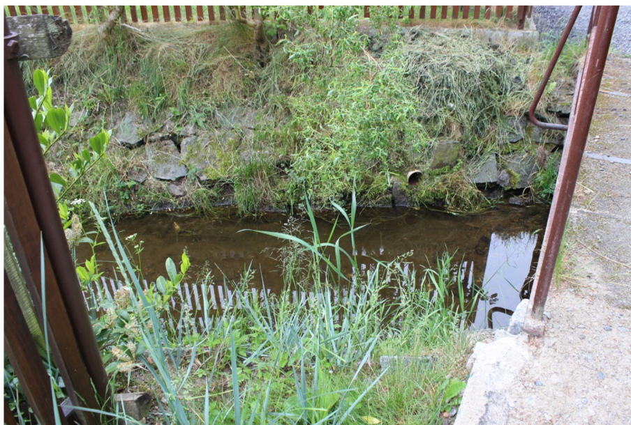
Obr. 3.1: Ukázka kamenné rovnániny
