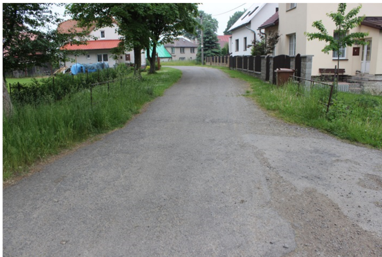
Obr. 3.10: Silniční most M1 - ř. km 0,1097
