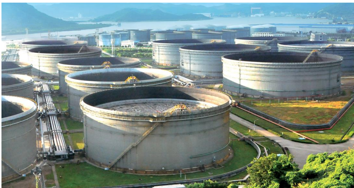
Obr. 1.11 Nadzemní stojaté válcové nádrže s plovoucí střechou [9]
