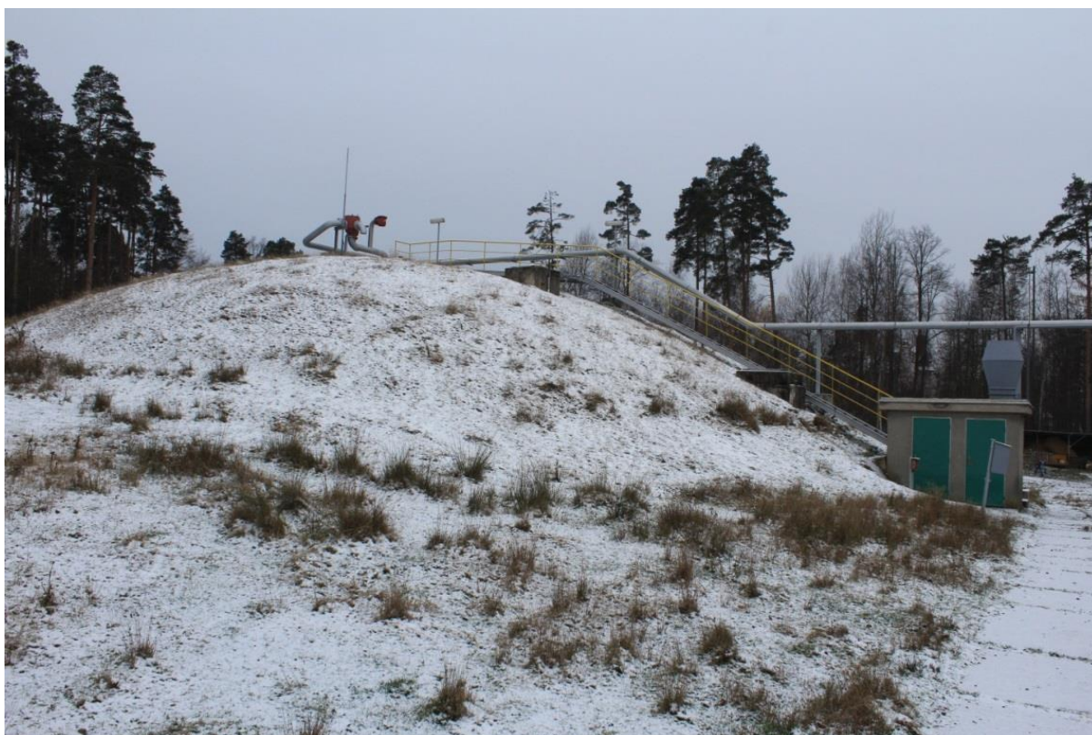
Obr. 3.1 Havarovaná nádrž ve Včelné – vnější pohled
