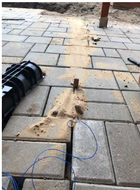
Obr. 7.6: Ukladanie vodiča popod dlažbu
