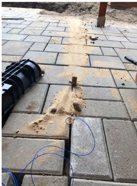
Obr. 7.6: Ukladanie vodiča popod dlažbu
