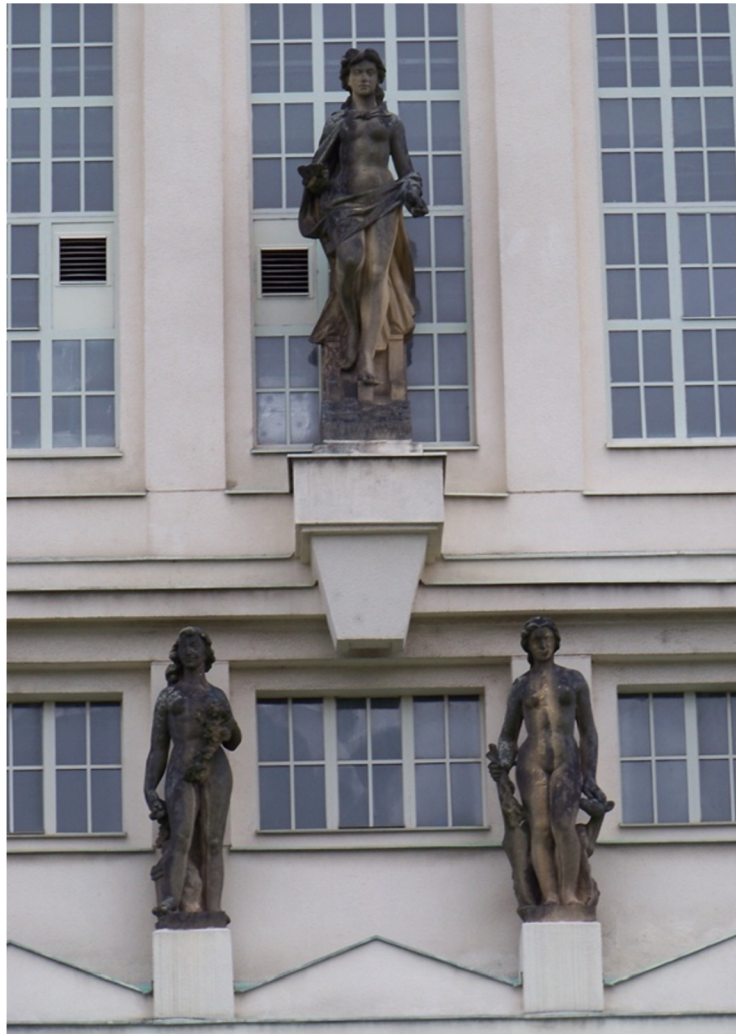
Obrázek č. 26, Alegorické sochy na průčelí vodárny v Praze-Podolí, nejvýše postavená představuje Vltavu, pod ní (zprava) Sázava a Berounka, autor fotografie: Jan Florentýn Báčor 2022. (soukromý archiv autora)
