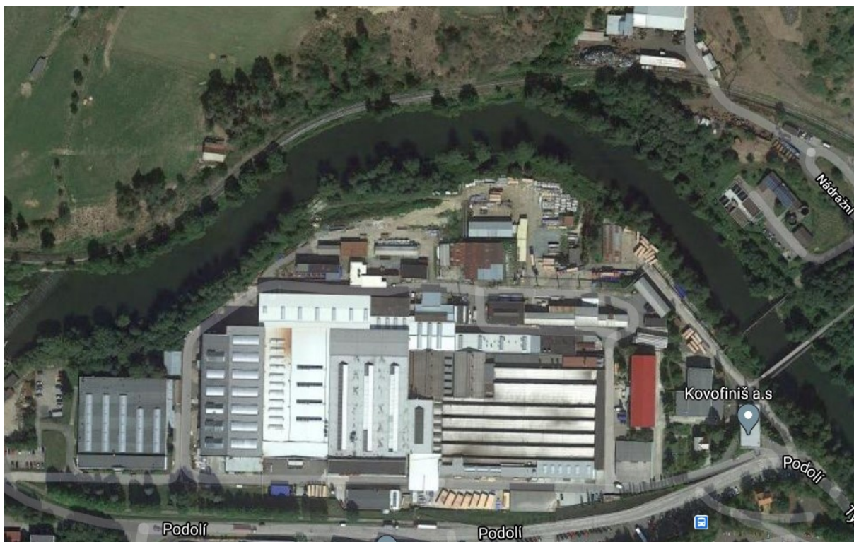
Obrázek 4: Areál KOVOFINIŠ a.s., Podolí 600, Leděč nad Sázavou
