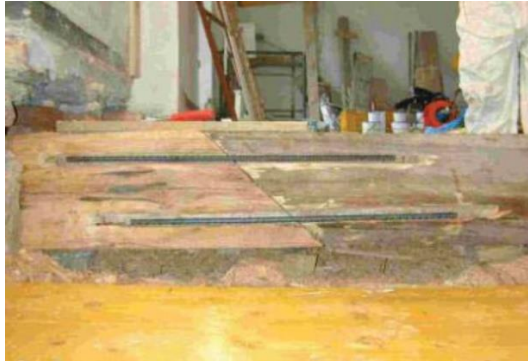
Obrázek 16) Oprava dřevěného nosníku pomocí CFRP lamel připevněné na povrchu zešikmeného spoje nového a stávajícího prvku [17].
