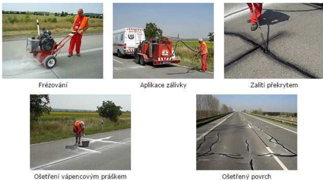
Obr. 25 Oprava trhlin [26]
