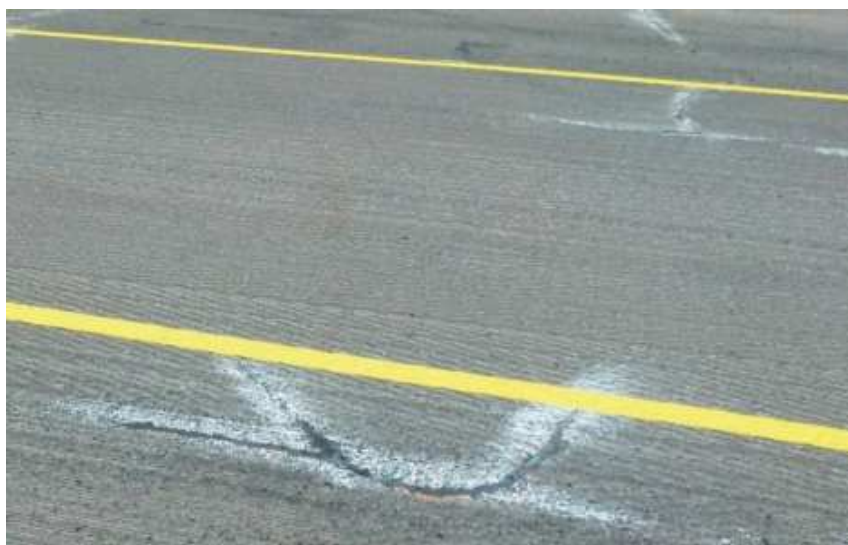
Obr. 29 Příklad opravy trhlin na obrusné vrstvě vozovky [31]
