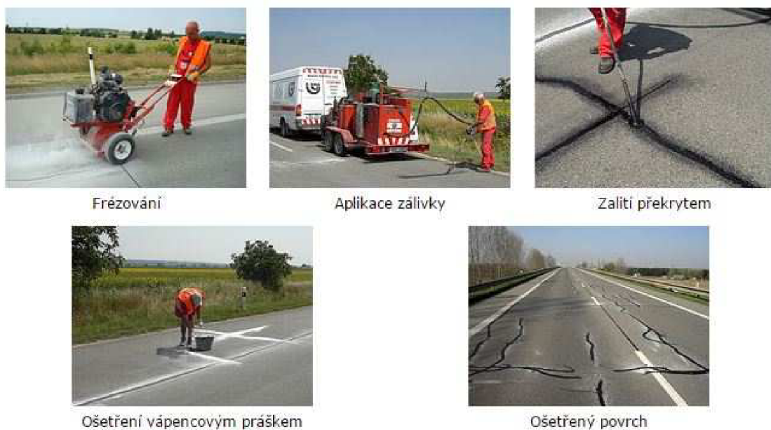
Obr. 25 Oprava trhlin [26]
