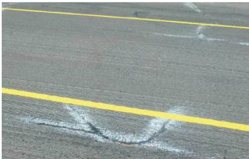
Obr. 29 Příklad opravy trhlin na obrusné vrstvě vozovky [31]
