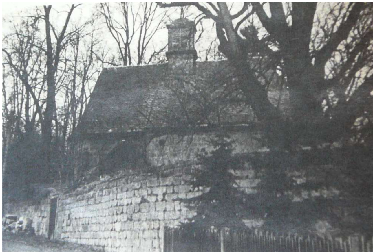
Obrázek 27 Stav kaple v 50. letech na nedatované fotografii z kroniky Augustina Šolce.
