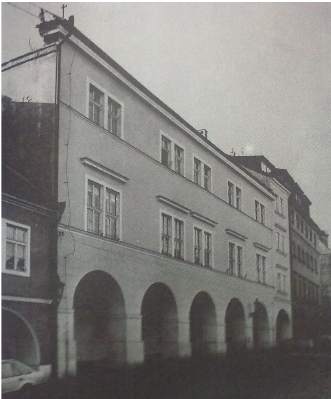
Budova Hradčanského ústavu
