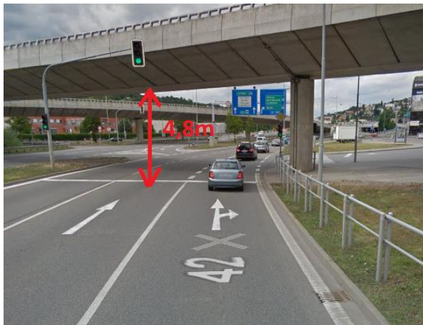
obrázek 7: Podjezd na ulici Bauerova
