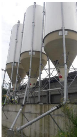
Obr. 5 Zásobníky krmných směsí (sila) s tenzometry
