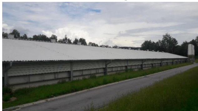
Obr. 9 Hala 7 - venkovní pohled
