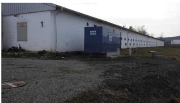
Obr. 8 Hala 1 - venkovní pohled
