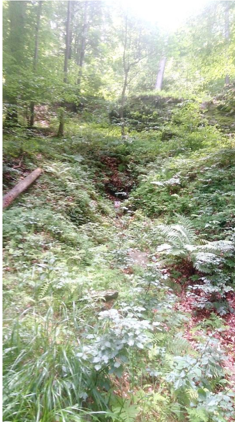
Obr. 22. Kosaře-Špičák, štola I téměř skryta pod lesním porostem (KOS-ŠP-I). Foto: Karolína Janků, červen 2022.
