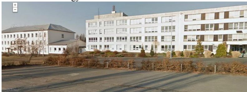
Obrázek 1 Budova gymnázia a Domu dětí a mládeže Astra
