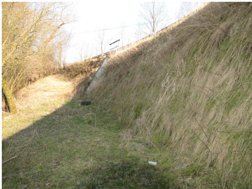
Obr. 23 Vnitřní oblouk vozovky s propustkem, aktuální stav
