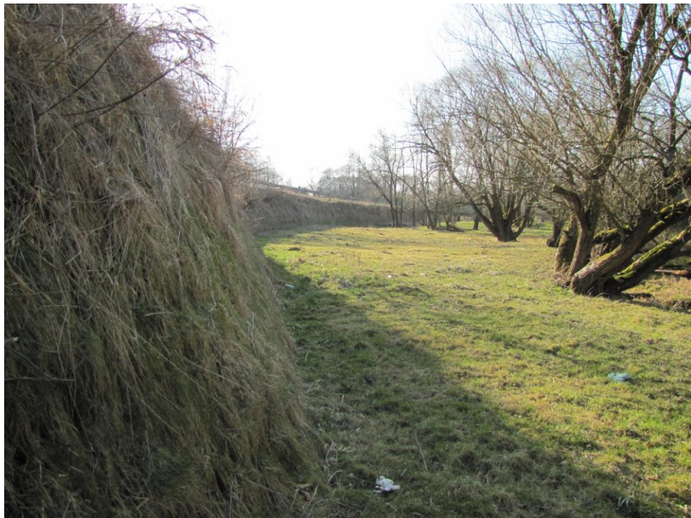
Obr. 25 Dokončené svahy, aktuální stav
