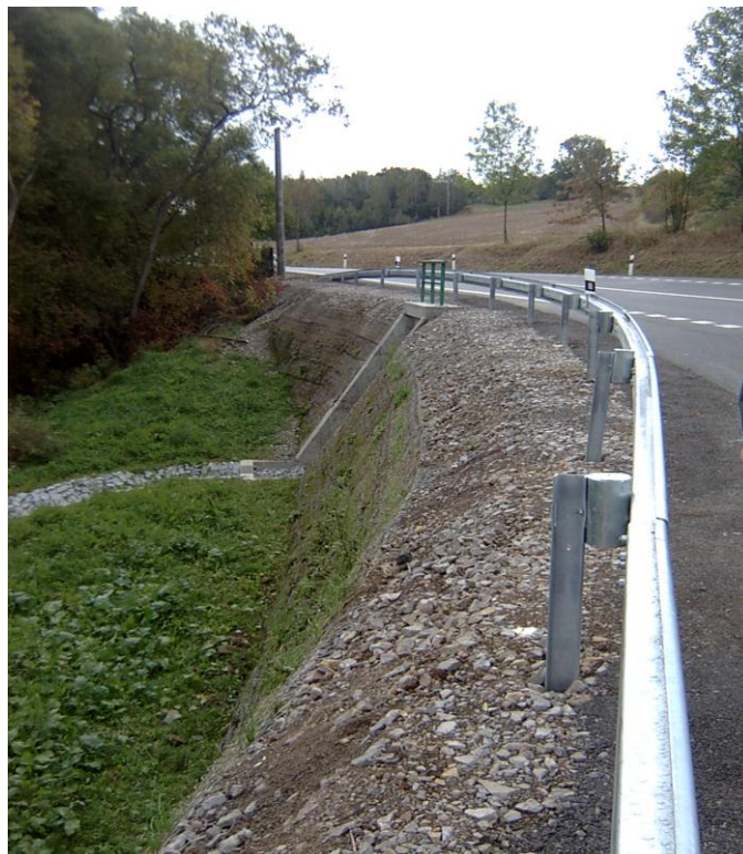
Obr. 22 Těleso SO 101 Přeložka komunikace I/19
