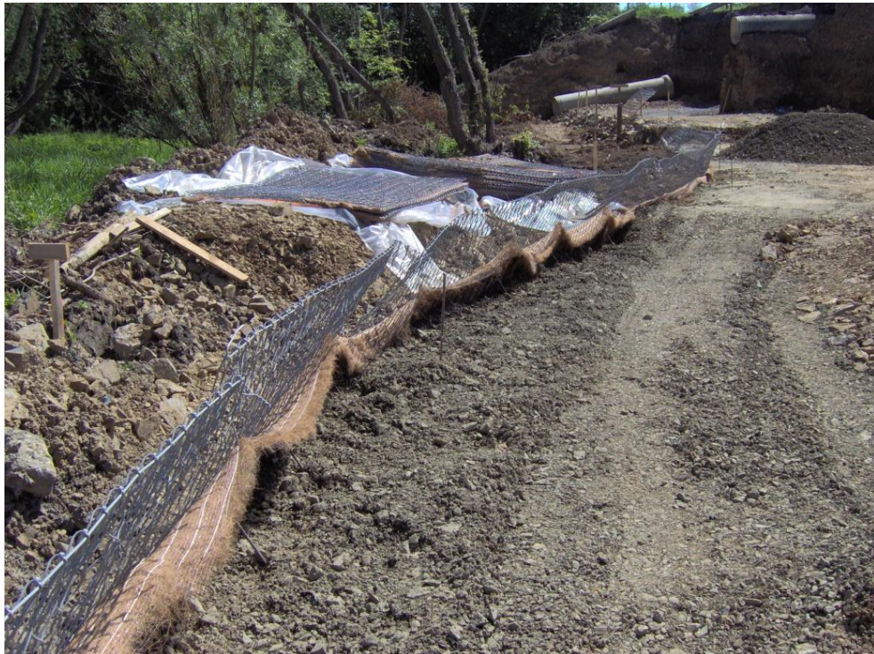
Obr. 16 První vrstva Terramesh po sanaci pláně
