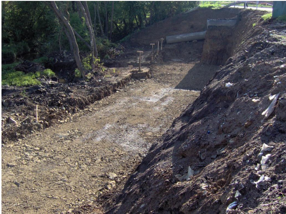
Obr. 15 Sanace pláně před pokládkou první vrstvy Terramesh
