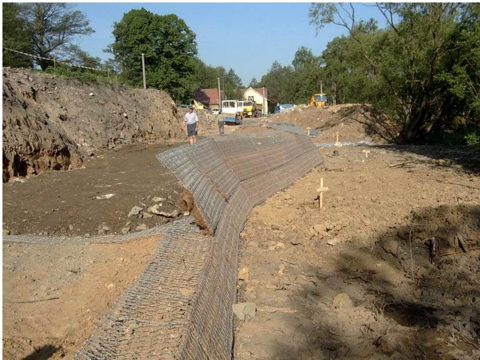
Obr. 17 Zaklopené pletivo před pokládkou další vrstvy
