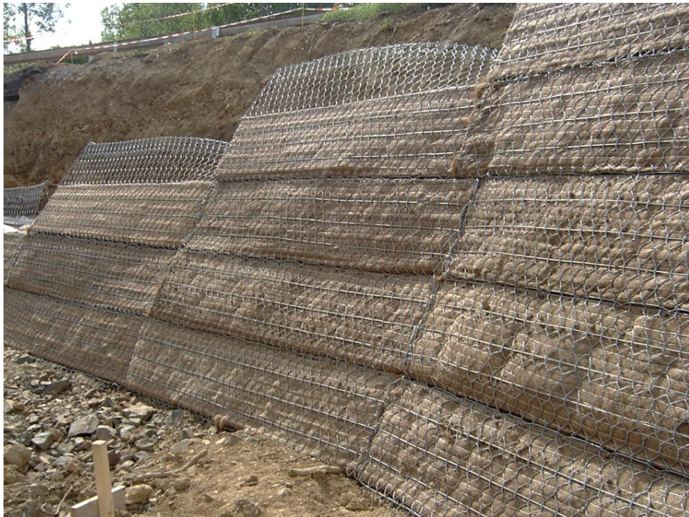
Obr. 19 Dosažení požadované strmosti, jednotlivé vrstvy Terramesh
