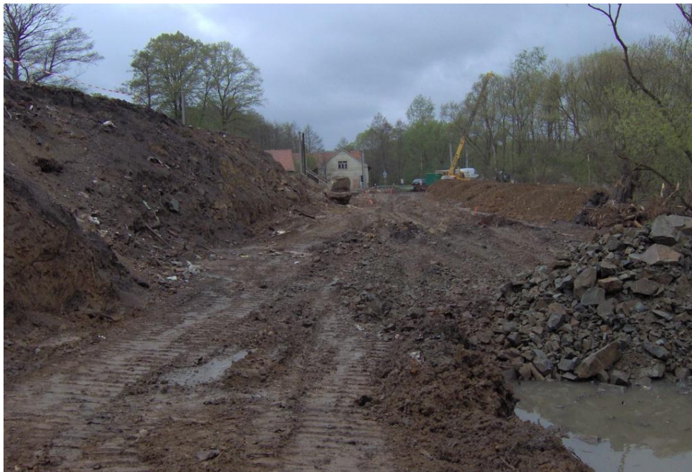
Obr. 14 Sanace silničního tělesa přeložky
