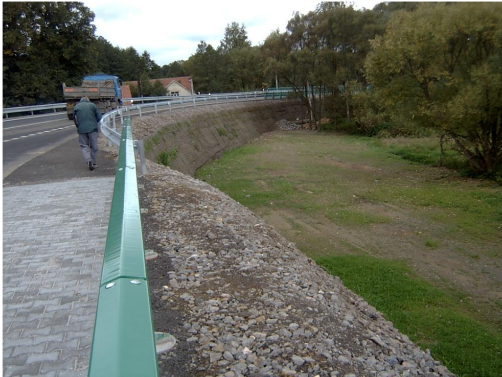
Obr. 24 Dokončené svahy a pohled na vzdálený mostní objekt
