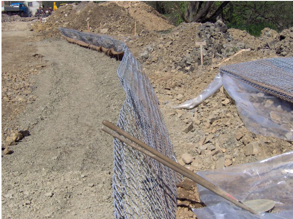
Obr. 18 Pokládání dalších vrstev dle technologického předpisu
