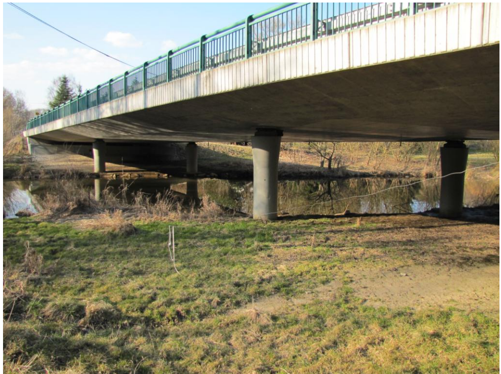
Obr. 12 Nový mostní objekt
