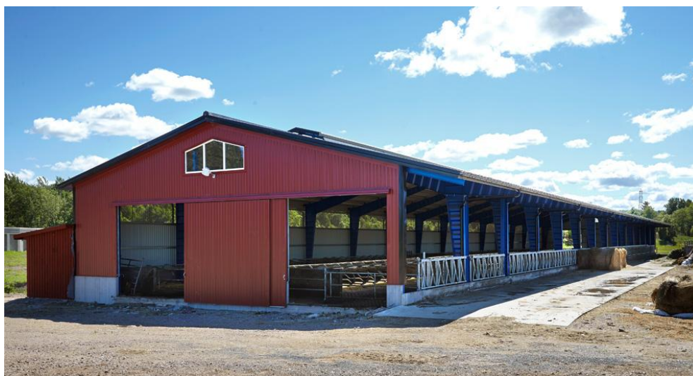
Obrázek č. 7 Ocelová hala exteriér [17]
