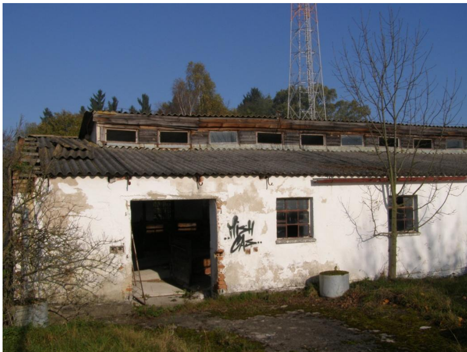
Vikýř ve střeše
