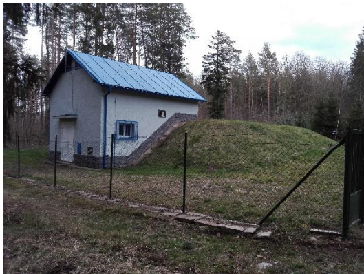
Obrázek 12: Vodojem Zálesí (autor)
