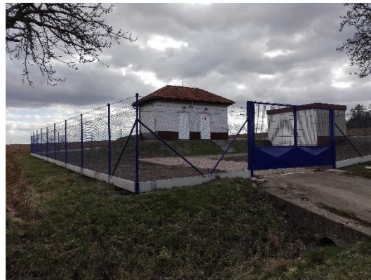
Obrázek 17: Vodojem a ČS Bykáň (autor)
