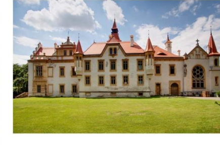
8. POHLED NA VÝCHODNÍ KŘÍDLO BUDOVY. PROSTOR BUDE
