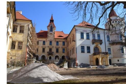
5. V SOUČASNOSTI JE CELÉ NÁDVORÍ V REKONSTRUKCI
