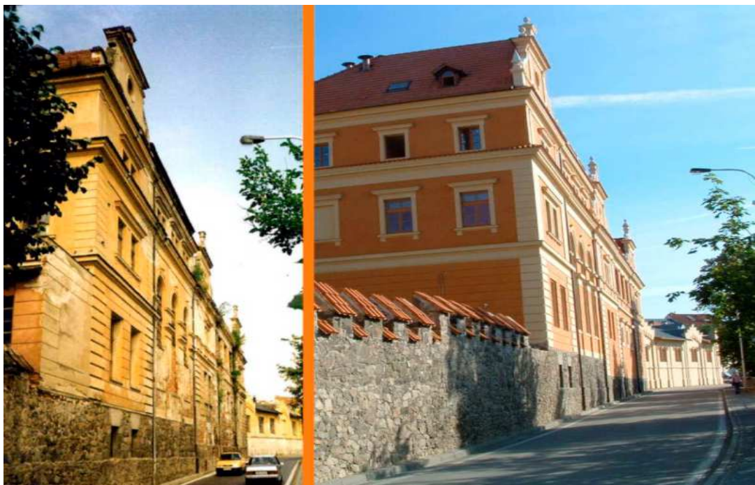
Obrázek č.2: Hotel Dvořák, jihovýchodní fasáda, stav před rekonstrukcí 2002 a stav po rekonstrukci 2004 (Zdroj: Galerie Dvořák, a.s.)
