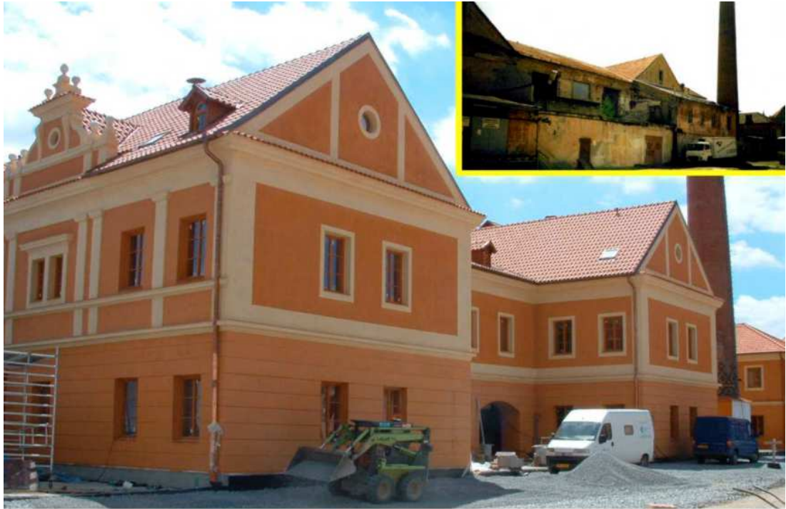
Obrázek č.3: Hotel Dvořák, severozápadní fasáda, stav před rekonstrukcí 2002, stav po rekonstrukci 2004 (Zdroj: Galerie Dvořák, a.s.)
