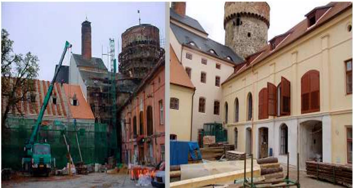
Obrázek č.4: Hrad Kotnov, pohled na věž Kotnov, kulturní a galerijní centrum - stav v průběhu rekonstrukce a po rekonstrukci (Zdroj: Galerie Dvořák, a.s.)
