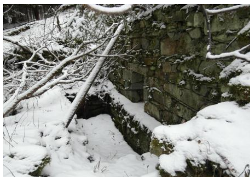
Obr. č. 9: Zbylá část mlýnice Bührenova mlýna
