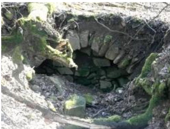
Obr. č. 4: Zavalený sklep ve Vranově
