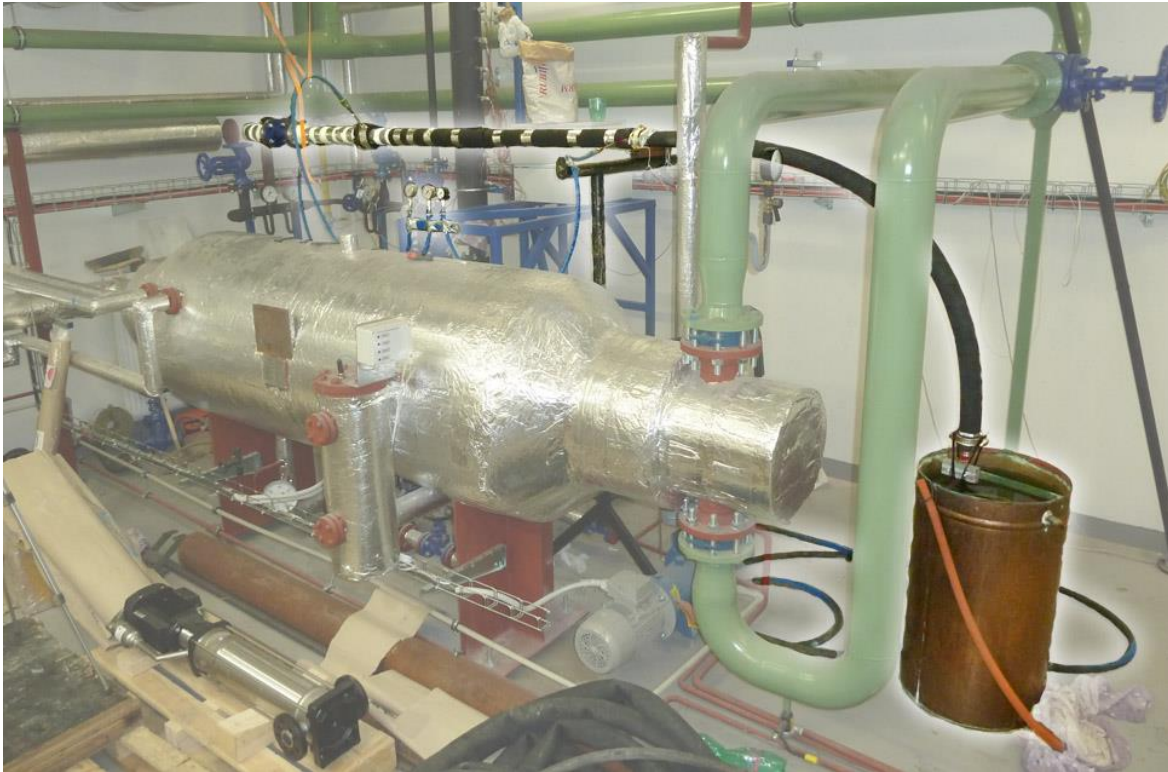
Obr. 24 Experimentální zařízení (zvýrazněno) - celkový pohled
