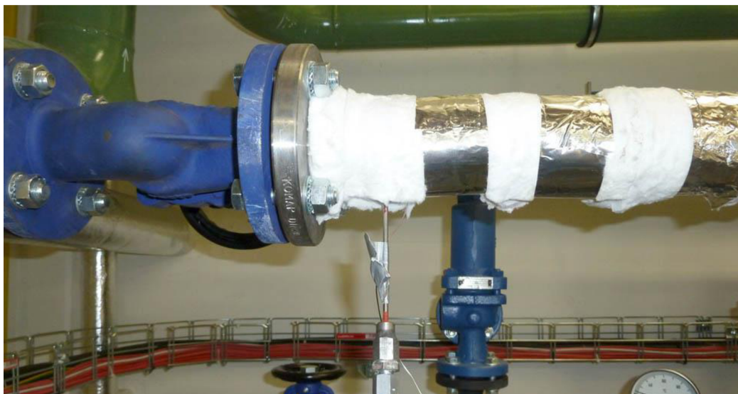
Obr. 26 Detail umístění sondy P1 a termočlásku T4
