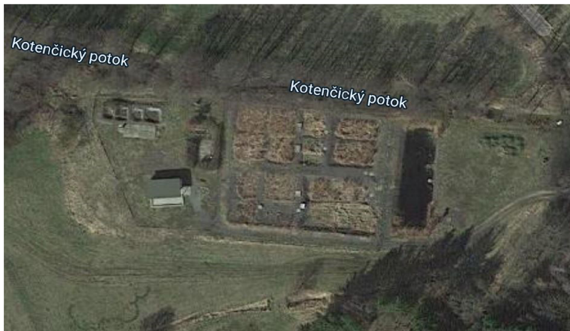
Obr. č. 11 Letecký pohled na kořenovou čistírnu odpadních vod Obec Kotečice (zdroj Google mapy)
