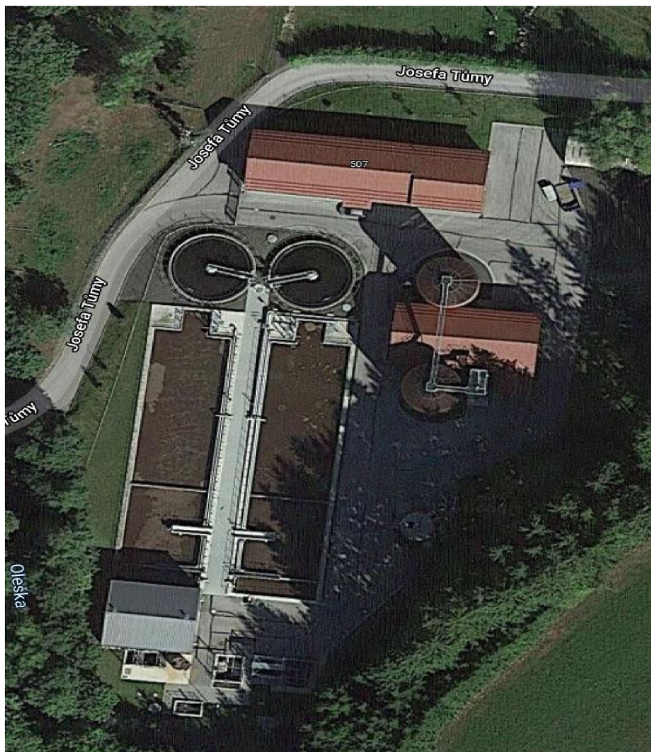
Obr. č. 8 letecký pohled na čistírnu odpadních vod (zdroj Google mapy)
